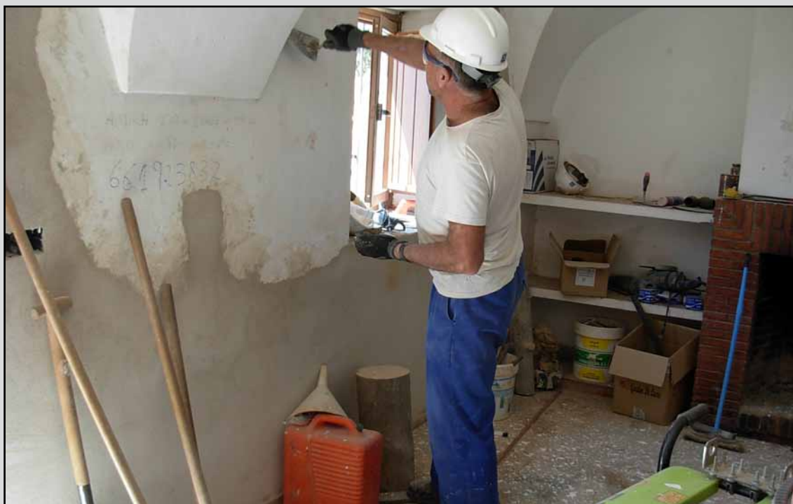
Trabajos de enfoscado para revestimiento de paredes en "Casa de Reyes" en el T.M. Villanueva del Rey (Córdoba). (Obra 03_CO_323_1 Proyecto de restauración, mejora y puesta en valor del patrimonio rural en montes públicos de la provincia de Córdoba).
