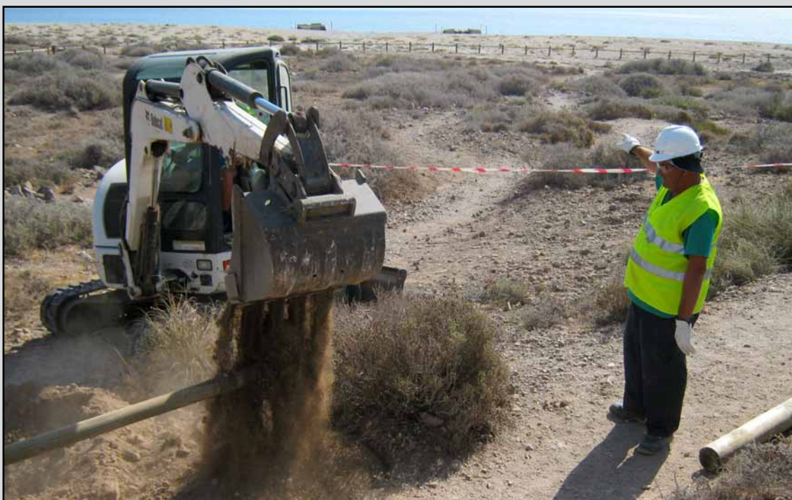
Colocación de vallado para conservación de ecosistemas naturales en PN. Cabo de Gata en el T.M. Carboneras (Almería). (Obra 01_AL_227_4_1 Conservación y mejora de flora y fauna en la provincia de Almería).
