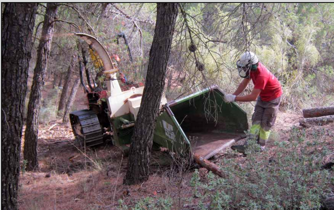
Astillado de fustes procedentes de labores de prevención de incendios en el T.M. Purchena (Almería). (Obra 01_AL_226_F2_2 Recuperación del potencial forestal e implantación de medidas preventivas en montes públicos de Almería).
