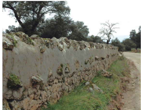
Foto 89. Restauración de pared de piedra tradicional que ha empleado abundancia de cemento para su sujeción.
