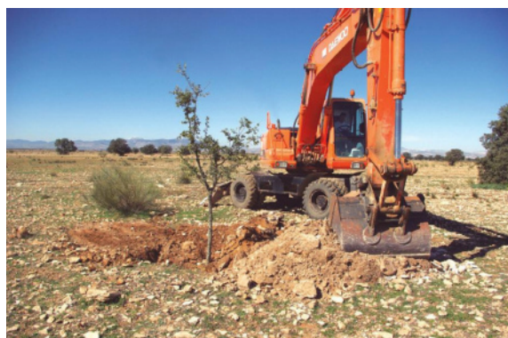
Foto 44. Ahoyado con retroexcavadora. Área experimental Cortijo del Conejo (Guadix, Granada).
