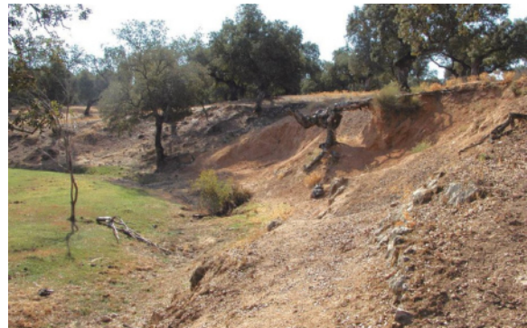
Foto 77. Erosión activa en cauce prácticamente desprovisto de vegetación de ribera.
