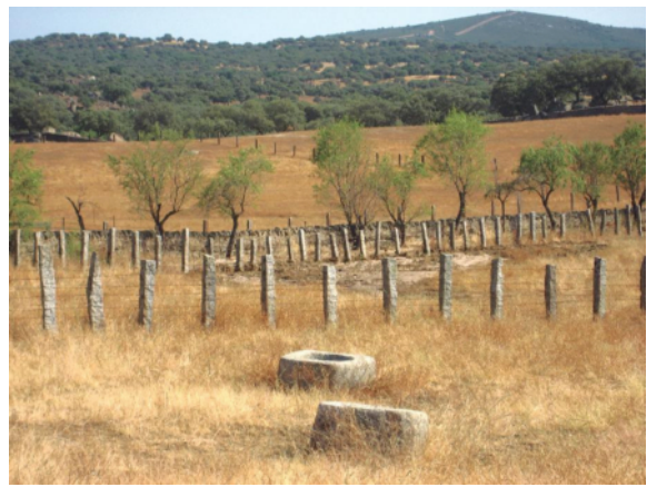
Foto 51. Postes de granito utilizados como soporte de los vallados.
