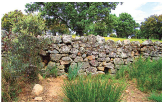
Foto 47. Ejemplo de pequeños huecos en una pared de piedra tradicional que sirven para evitar la acumulación de agua en las zonas bajas y facilitan el paso de la fauna silvestre.
