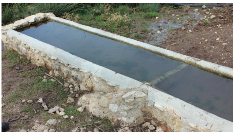
Foto 35. Abrevadero adaptado con una rampa exterior e interior para favorecer la entrada y salida de anfibios y de otras especies que pudieran caer accidentalmente.
