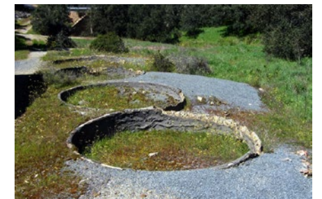
[117] Instalaciones industriales de la mina del Arroyo Cerezo
