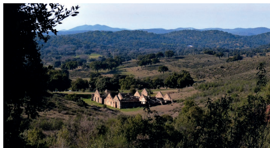
[255] Panorámica de ruinas de equipamientos mineros
