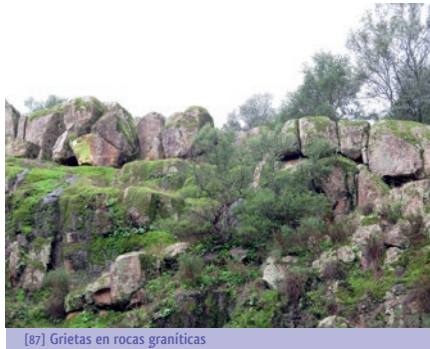
[87] Grietas en rocas graníticas
