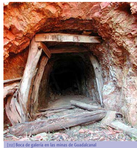
[112] Boca de galería en las minas de Guadalcanal
