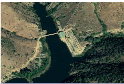
[148] Localización de la central hidroeléctrica de El Pintado
