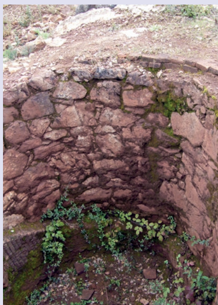
[120] Restos de una de las caleras de Cerro del Hierro
