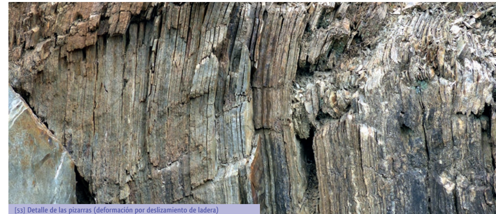
[53] Detalle de las pizarras (deformación por deslizamiento de ladera)
