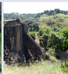
[145] Molino hidroeléctrico en el Rivera del Huéznar
