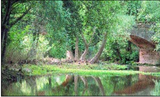
Puente sobre el río Hueznar.
