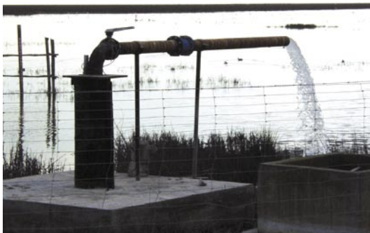
Foto 3. Modificación del flujo del agua por extracciones del freático para conservación de especies. Lucio junto al Centro de Interpretación JA Valverde.
