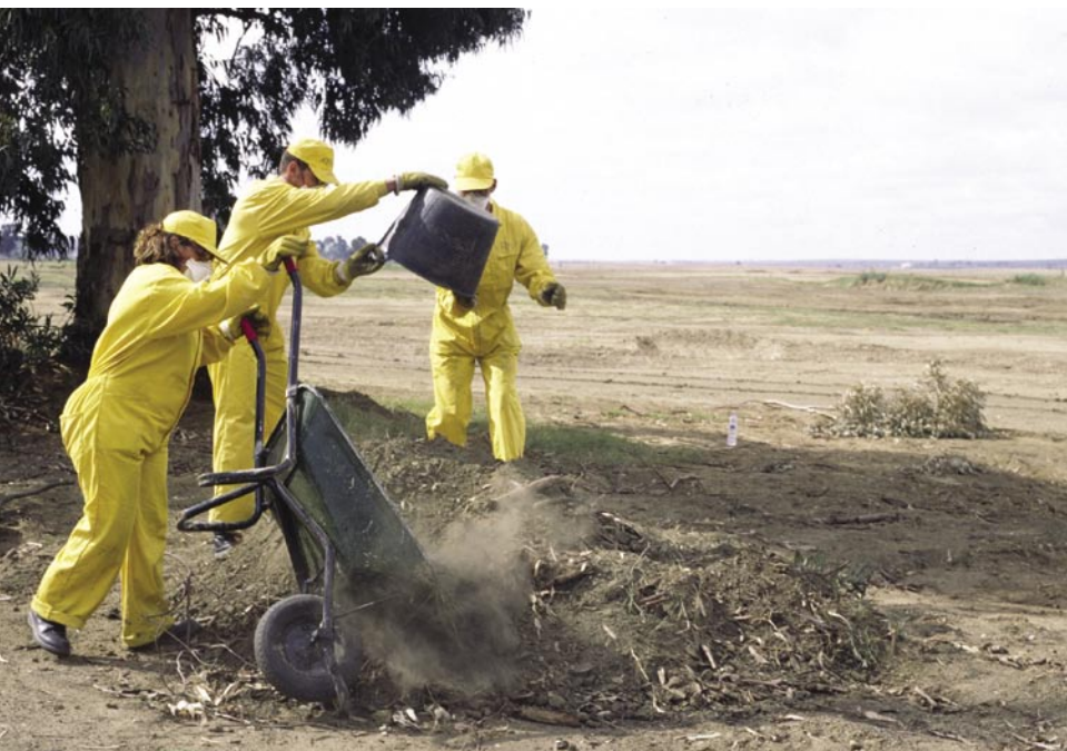
Foto 9. Labores de retirada manual de lodos y suelos contaminados: Foto: CMA.
