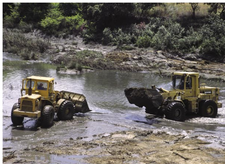
Foto 10 y 11. Labores de retirada mecánica de lodos en el cauce del río Guadamar. Foto: CMA.
