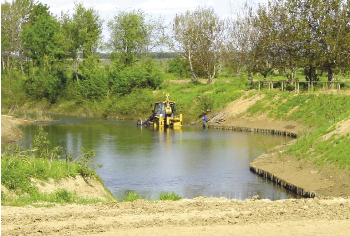
Foto 19. Labores de adecuación de márgenes en el Vado del Quema al objeto de reducir la erosión del río en momentos de avenidas. Foto: CMA.
