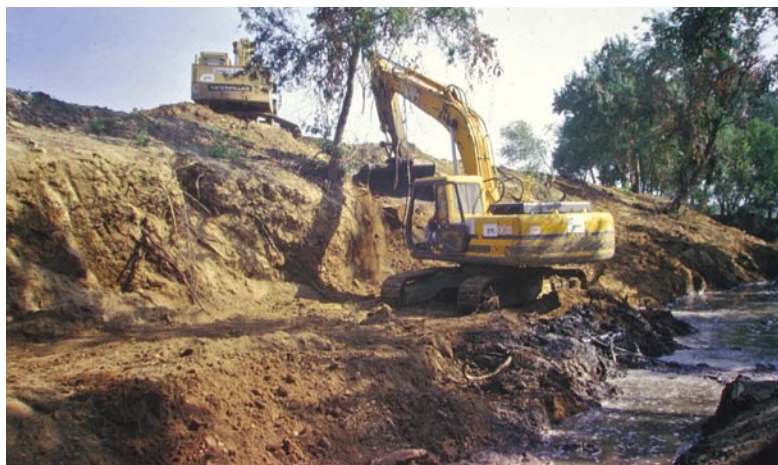
Foto 14. Labores de limpieza y acondicionamiento de taludes. Foto: CMA.
