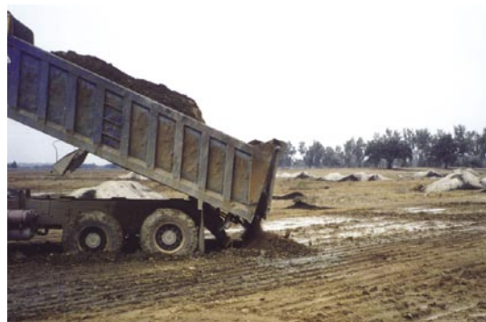
Foto 24. Aportes de materia orgánica en la corrección de los suelos. Foto: CMA.
