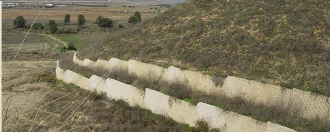
Foto 27 y 28. Detalles del estado del mirador antes de la restauración (escombrera abandonada) y después. Fotos: CMA.
