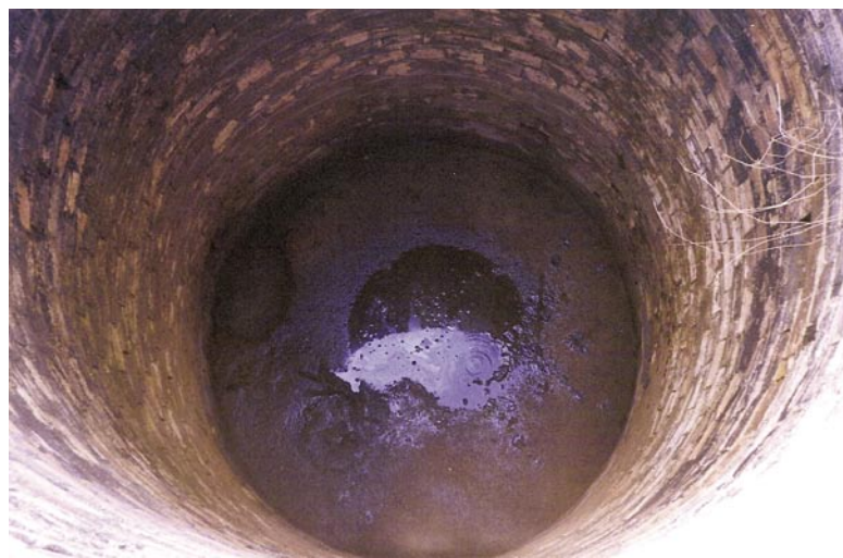
Foto 1. A) Aspecto de uno de los pozos agrícolas de gran diámetro rodeado por restos de lodo del vertido. B) Aspecto del interior de un agrícola con partículas de lodo aún en el interior.
