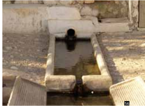
Surgencias en la solana: Las Fuentes
