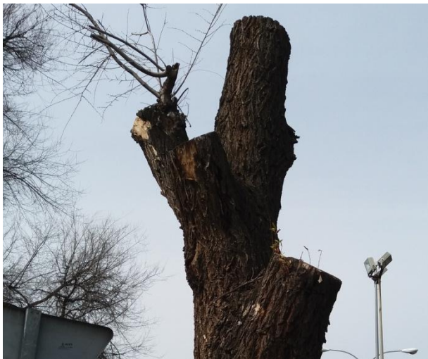
Ilustración 67. Una poda estructural incorrecta o ausente durante los primeros años de vida de un árbol, o una poda traumática en los siguientes crean una situación viciosa y viciada que se perpetúa y extiende con continuas podas inapropiadas durante toda la vida del árbol con el fin de aligerar la masa leñosa de un individuo estructuralmente inestable.
