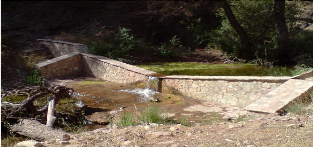
Dique nº 2, intermedio, salvaguarda 1km de tramo
