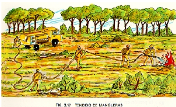
FIG. 3.17 TENDIDO DE MANGLERAS
