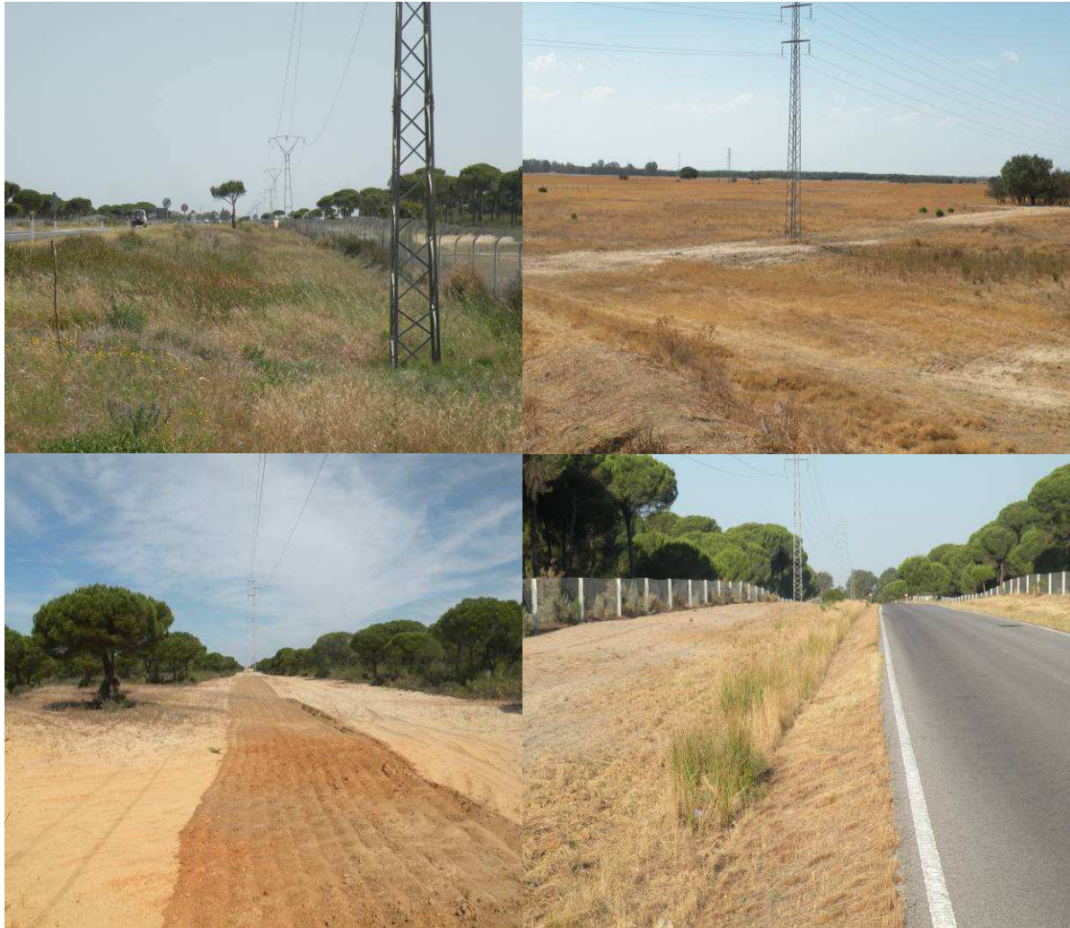
Líneas eléctricas en distintas fases del mantenimiento.
