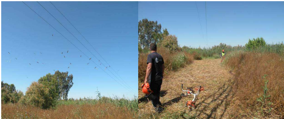
Apertura de vía de acceso. Antes y después
