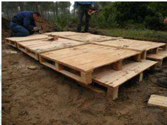
Imágenes de las plataformas estructurales de palets y de los majanos terminados con cercado
