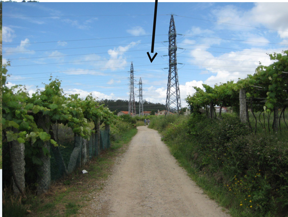
Entorno futura SE 220 kV Tomeza Camino portugués de Santiago
