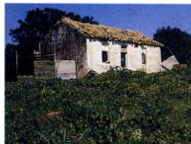
Edificaciones abandonadas, nos hablan de pasadas actividades económicas de la zona.
