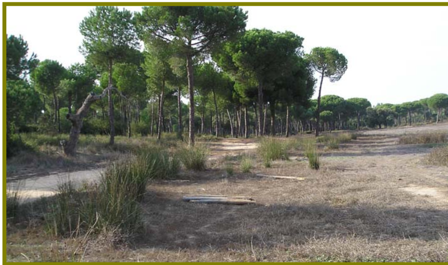
En la fecha de la visita solo quedaban en pie algunos tramos del vallado de cierre de la laguna. El deterioro de este cerramiento ha facilitado el acceso de visitantes al interior de la cubeta y la presencia de residuos en su interior.
