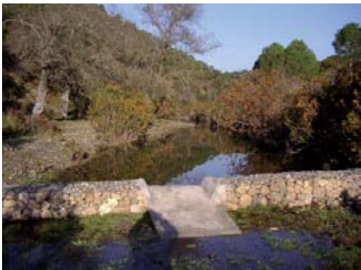
Azud elaborado para la creación de pequeñas láminas de agua
