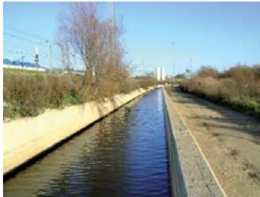
Canal situado al norte de la laguna de Los Prados, entre ésta y los talleres de RENFE
