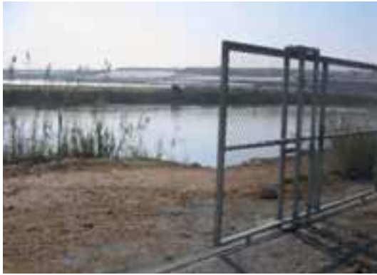
Acceso del vallado instalado
