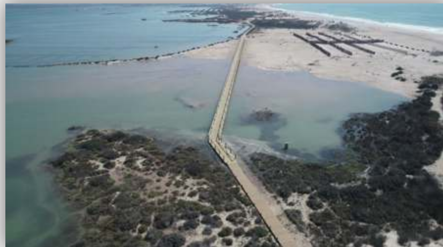
Vista aérea de la pasarela (© Junta de Andalucía)
