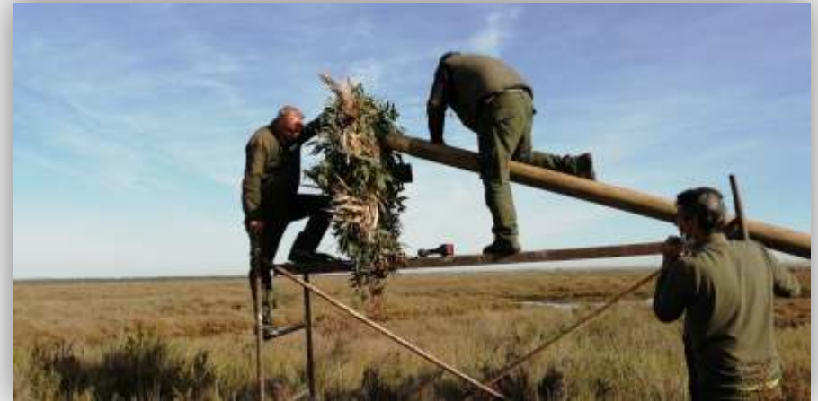
Construcción de posadero (© Junta de Andalucía)
