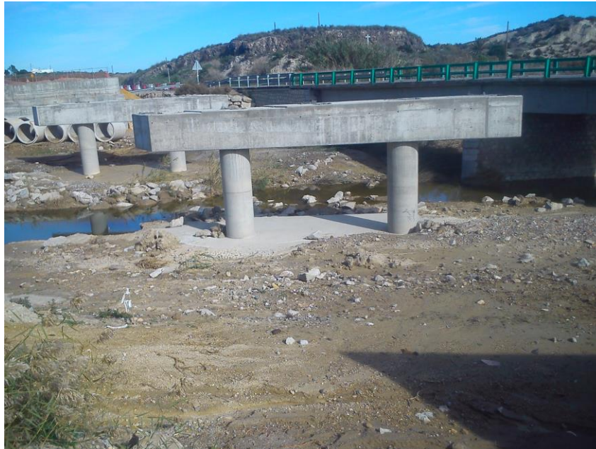
Figura 5: Construcción de nuevo puente sobre la carretera A-352.
