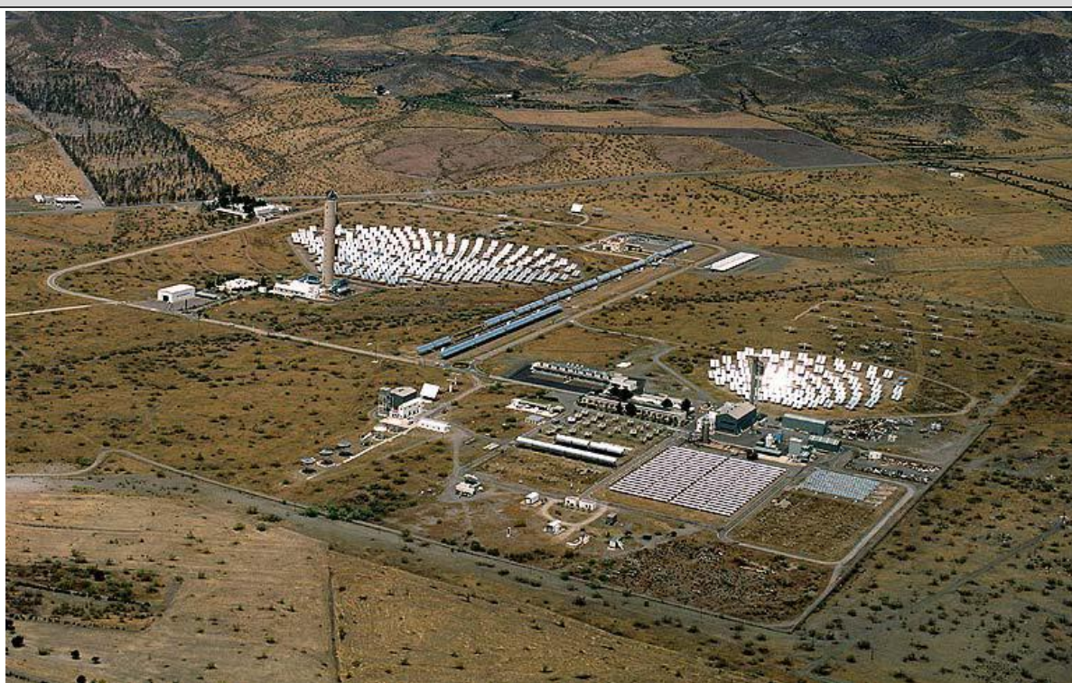
Figura 123. Vista aérea de la Planta Solar de Almería
