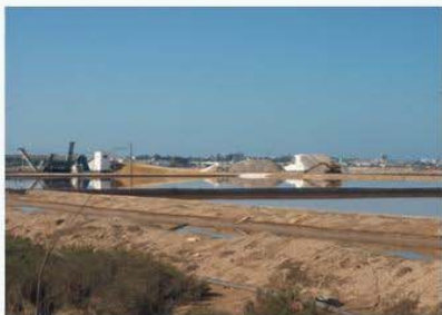
DPMT- Instalaciones de una salina industrial
