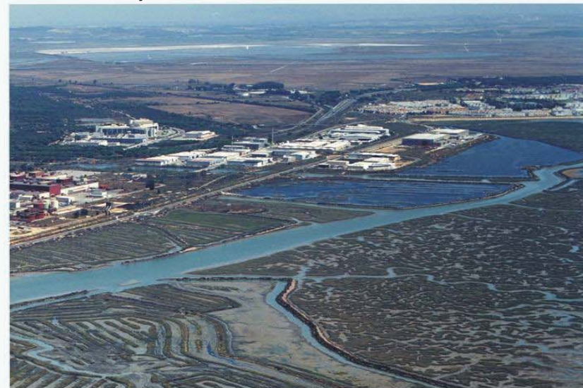
Fotografía oblicua del tramo en la que se aprecia el polígono industrial y la antigua salina de La Covacha (inundada en la zona derecha), con una parte de la Isla del Trocadero en la zona inferior
