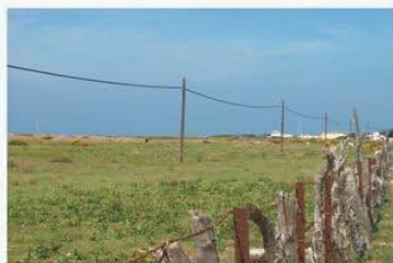
ZSP- Tendido eléctrico y uso ganadero
