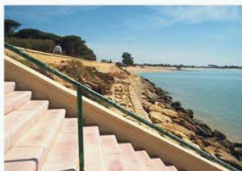
DPMT- Acceso y escoltera al pie del paseo
