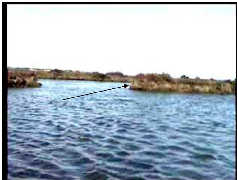
Este hecho fue evidente en los muros de los cristalizadores de la zona de actuación (figura 3). Por otro lado, los muros que separaban la zona de los cristalizadores de la zona de los canales de evaporación también sufrieron roturas (ver figura 21) quedando unidas diferentes estructuras de la salina.
