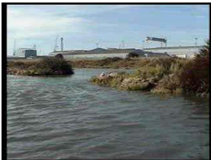
Por otro lado las pendientes de las orillas de los muros que separan los cristalizadores habían aumentado su superficie debido a los desprendimientos de la parte superior de los muros producidos por la erosión del agua en dichas pleamares vivas. Al mismo tiempo, dicha parte superior disminuyó su superficie y sus pendientes se perdieron, formándose pequeños taludes (figura 24).
