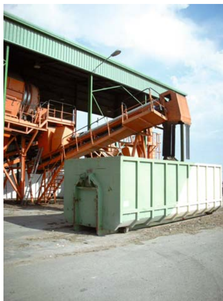
Planta tratamiento de compost de residuos urbanos
