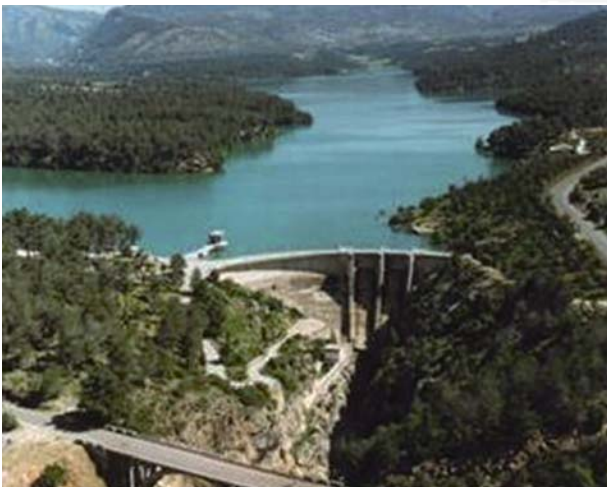
Presa La Bolera
