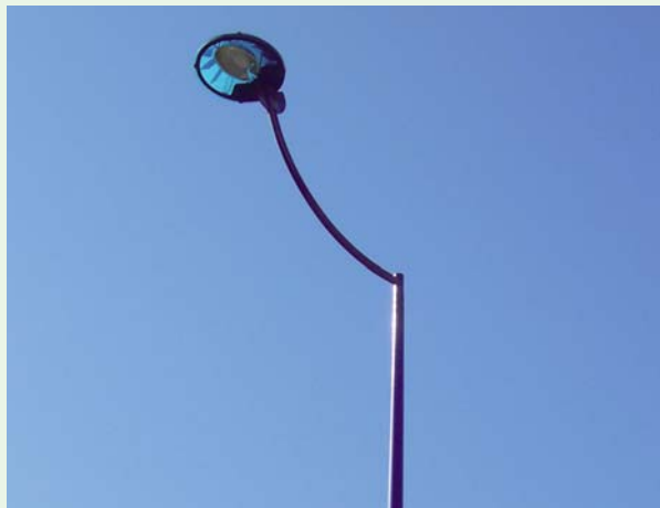
Instalación de alumbrado exterior
