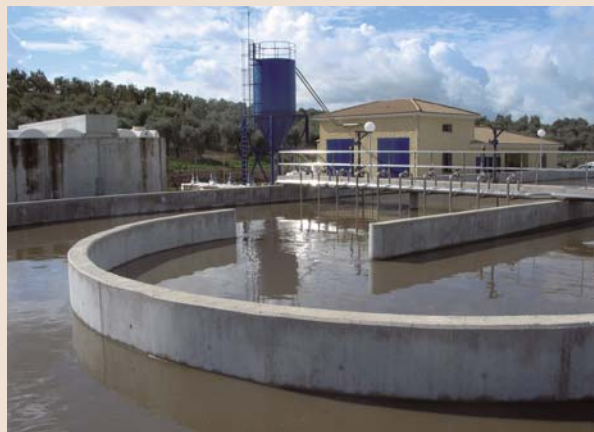
EDAR de Morón de la Frontera (Sevilla)
