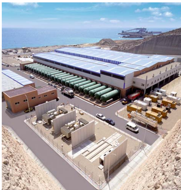
Desaladora de Carboneras (Almería)
