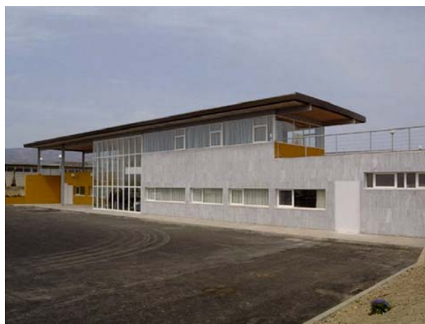
Instalaciones de la EDAR El Toyo en Almería
