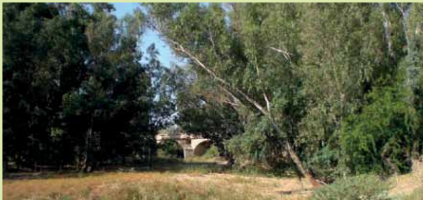
El puente de la Cartuja (Jerez de la Frontera) antes de la intervención
