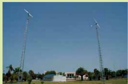
Planta piloto nanofiltración con vista de los aerogeneradores.
