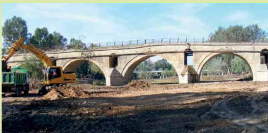
El puente de la Cartuja después de la intervención.
