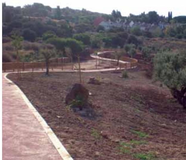
Adecuación del Cordel de Benahavís a Ojén, en Marbella (Málaga)
