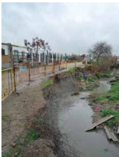
Pérdida de suelo por lluvias torrenciales.
