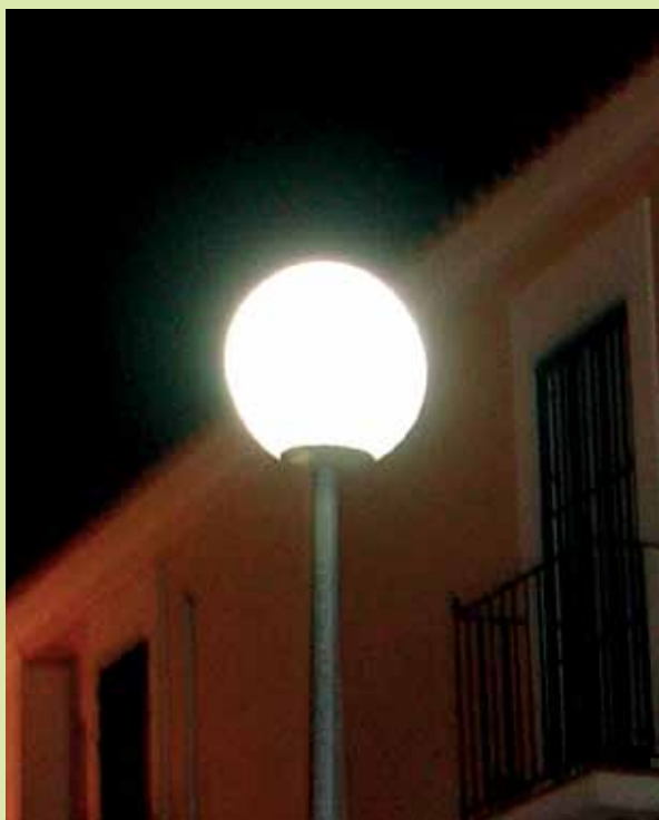
Emisión lumínica inadecuada de una farola
