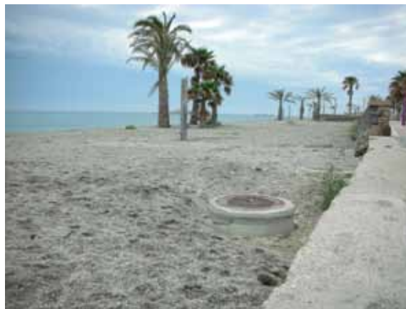
Red de saneamiento municipal. Costa de Almería
