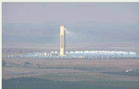
Plataforma de Solúcar de Abengoa en Sanlúcar la Mayor
