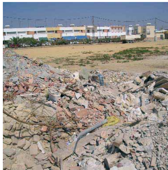
Residuos de demolición
