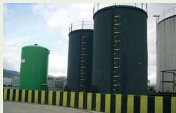
Almacenamiento de residuos MARPOL en un puerto andaluz
