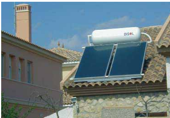
Instalación de placa solar
