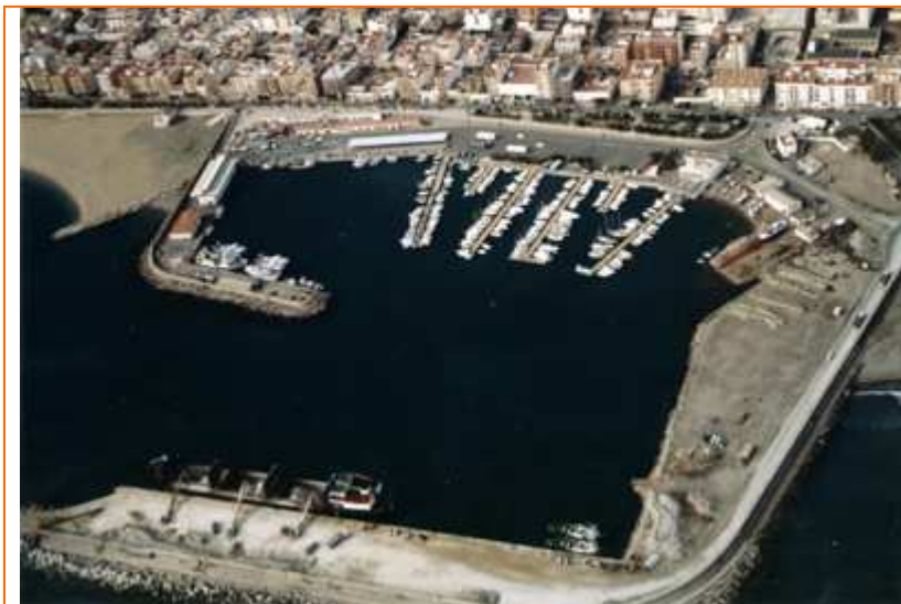
Figura 4.40. Vista aérea del puerto de Garrucha
