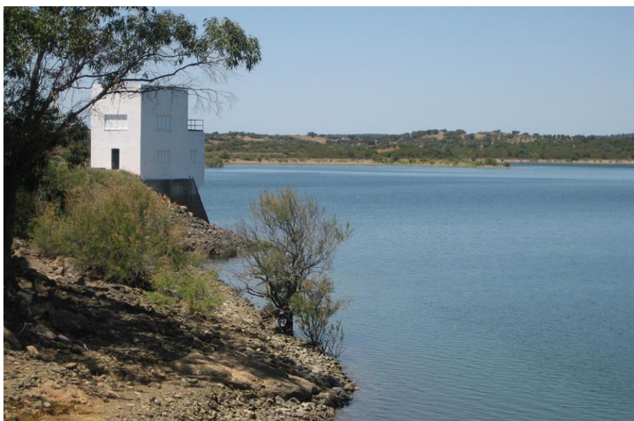
Figura nº 9. Presa del Piedras
