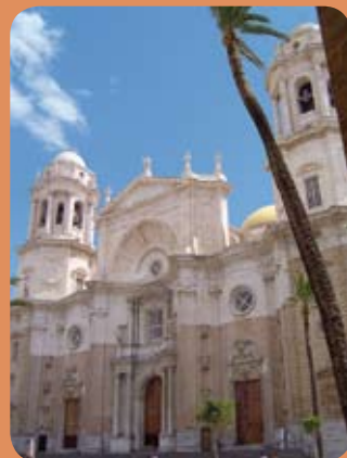
Cuerpo inferior de la Catedral de Cádiz, realizado a base de cantería con piedra ostionera de la zona.
