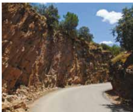
Trinchera por la que pasa la carretera
