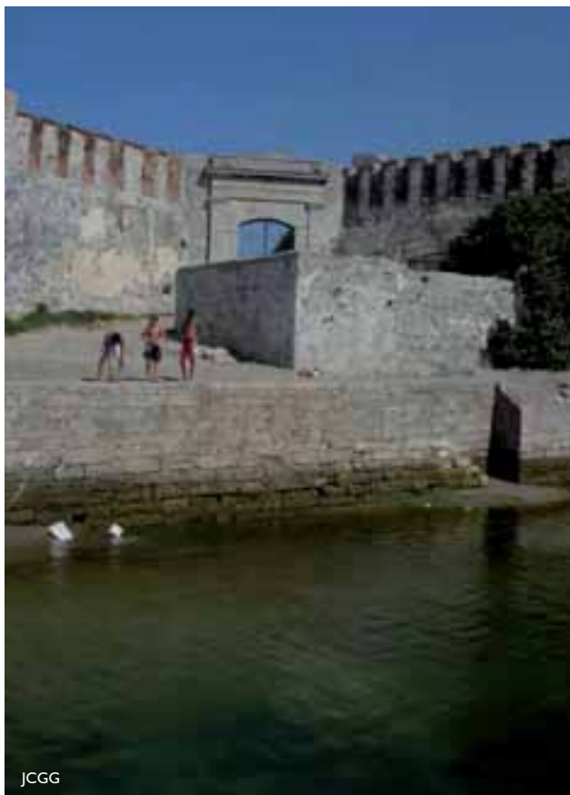
Puerta dintelada, antigua entrada a la Isla por su lado de poniente, en El Foso.
