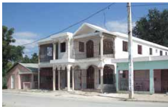
Casas de block en construcción
