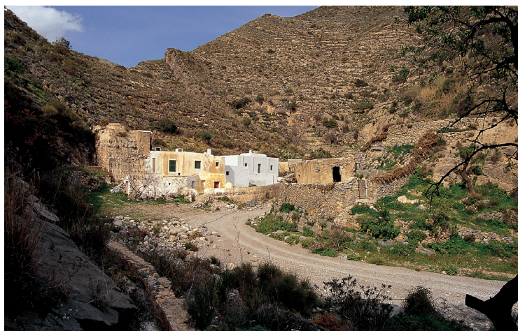
Paraje del Rincón del Molino, sobre la rambla de Carcauz, con las acequias y otros dispositivos hidráulicos del molino de Luis Faba, en la Sierra de Gádor (Almería).
