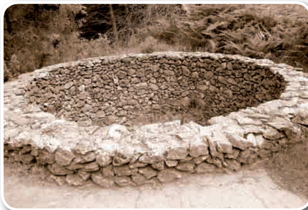
Nevero reconstruido junto al Puerto Saucillo en la Sierra de las Nieves.
