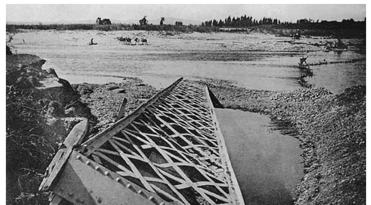
Tramo metálico del primitivo puente-sifón de la Florida arrastrado por la gran riada del Guadalete de 1917, en fotografía de E. Hernández Pachecho.
