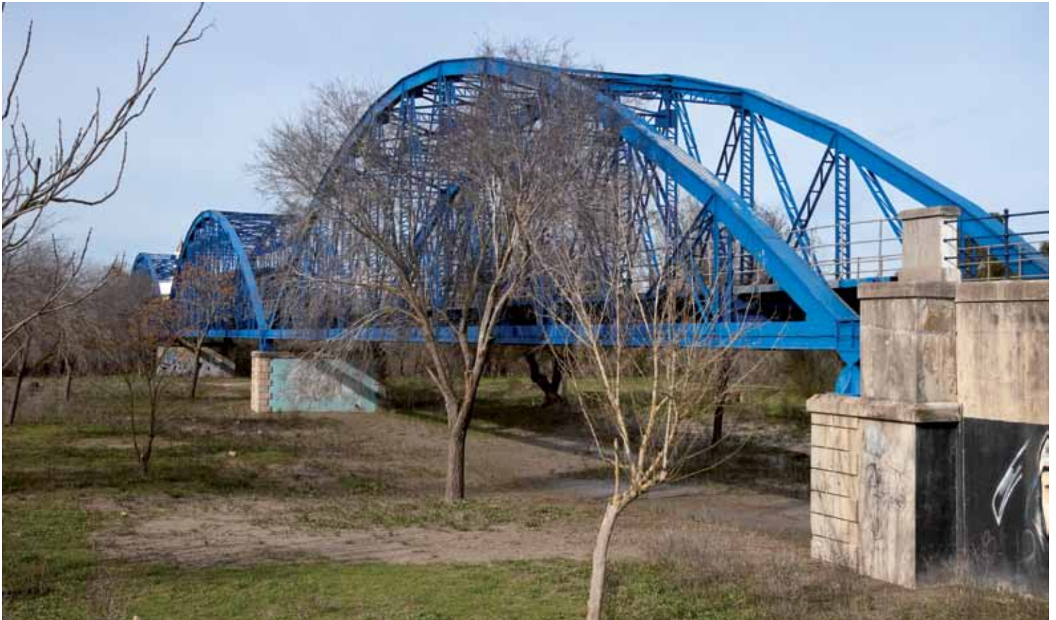
Puente de la Florida, construido en 1924 y ampliado en 1936. Foto: J. Morón.
