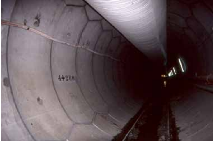
Interior del túnel de trasvase, de algo más de doce kilómetros de longitud. Foto: CONFEDERACIÓN HIDROGRÁFICA DEL GUADALQUIVIR.
