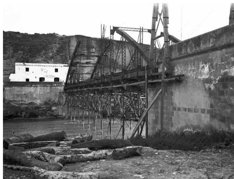
El nuevo puente de hierro de San Miguel durante su construcción en 1919, desde el Barrio Bajo.
