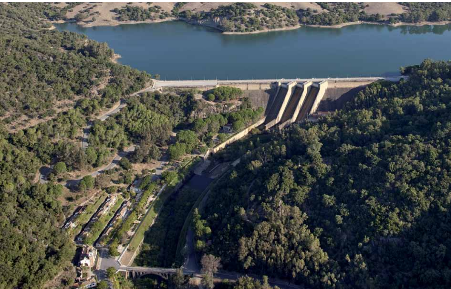
Vista aérea del conjunto del embalse, la presa y el poblado de los Hurones, situado en primer término, junto al puente sobre el río Majaceite. FOTO: J. HERNÁNDEZ.
