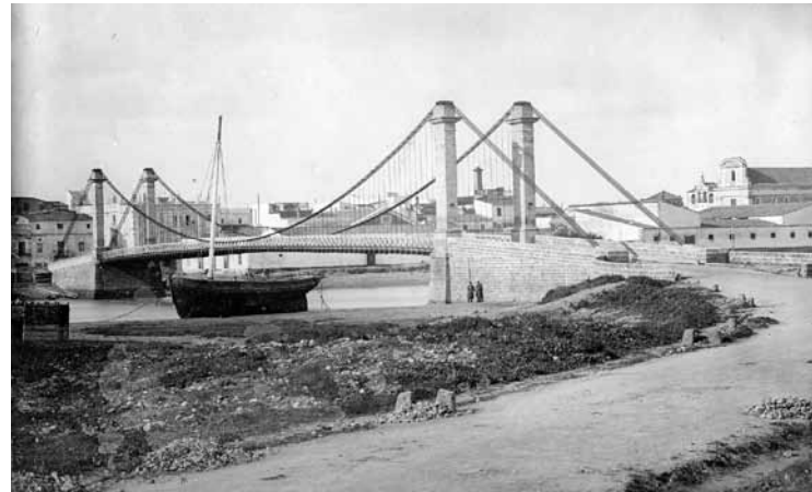
Puente colgante de San Alejandro, paso sobre el Guadalete en El Puerto de Santa María entre 1846 y 1877, en una fotografía de J. Laurent tomada hacia 1867. ARCHIVO RUIZ VERNACCI. FOTOTECA DEL PATRIMONIO HISTÓRICO, INSTITUTO DEL PATRIMONIO CULTURAL DE ESPAÑA, MINISTERIO DE EDUCACIÓN, CULTURA Y DEPORTE.
