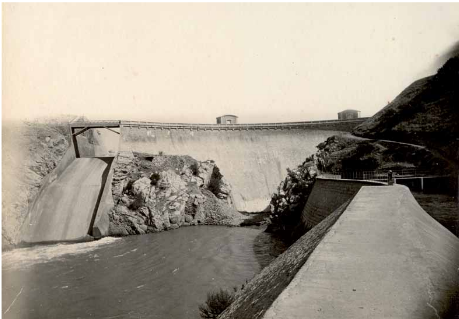
La primitiva presa de Guadalcacín, en 1913. A la izquierda se observa el aliviadero, en el centro la pantalla de la presa y a la derecha, el arranque del canal de riego. FOTO: CONFEDERACIÓN HIDROGRÁFICA DEL GUADALQUIVIR
