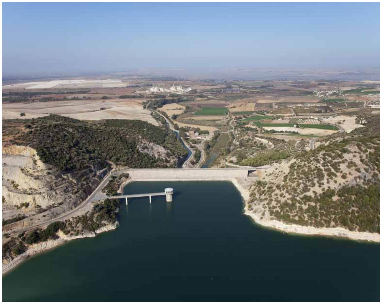
Vista del embalse de Guadalcacín II hacia aguas abajo, con la campiña del Guadalete y la Zona Regable del Guadalcacín al fondo. FOTO: J. HERNÁNDEZ.
