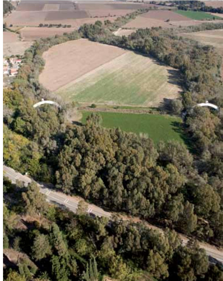
Paraje de la Junta de los Ríos Majaceite y Guadalete, con los sifones sobre los cauces. Foto: J. HERNÁNDEZ.
