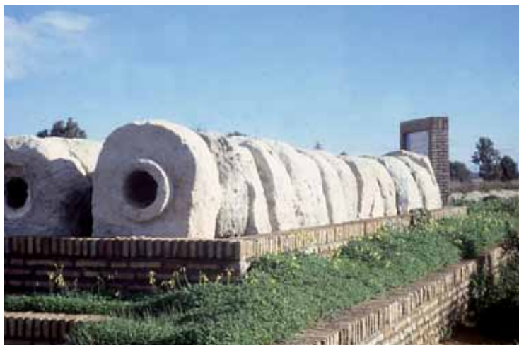
Encañado de las conducciones romanas del acueducto de Tempul.
