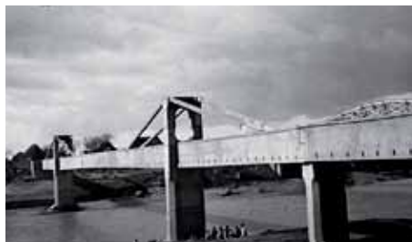
Acueducto-sifón de Tempul recién terminado en 1927. COLECCIÓN TORROJA, CENTRO DE ESTUDIOS HISTÓRICOS DE OBRAS PÚBLICAS.
