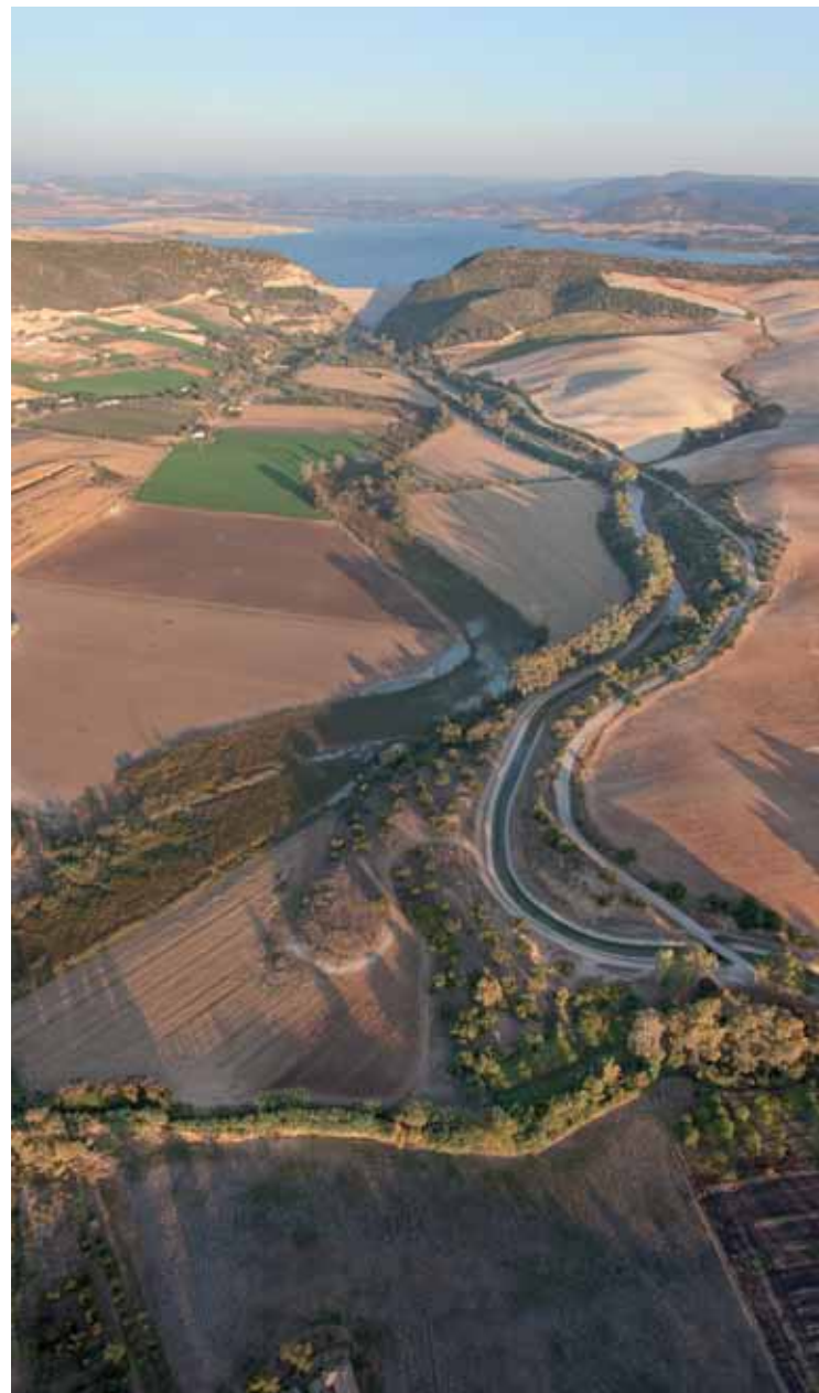
Vista de la presa y embalse de Guadalcaacín II desde aguas abajo. A partir de la presa se distinguen, a la izquierda, el cauce del Majaceite, jalonado por una densa vegetación, y a la derecha, la gran canalización de conducción de aguas para los regadíos. Foto: J. Hernández.
