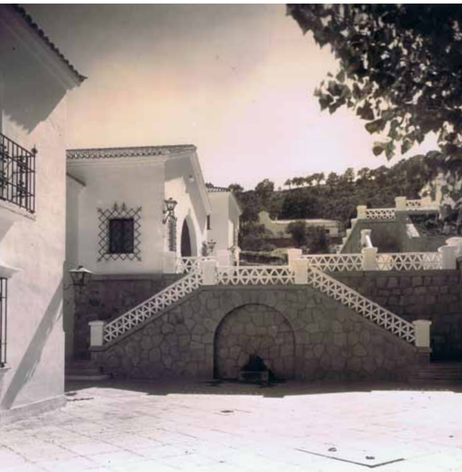
Detalle de la mampostería de piedra arenisca y otras fábricas empleadas en la obra del poblado. ARCHIVO AYCART.
