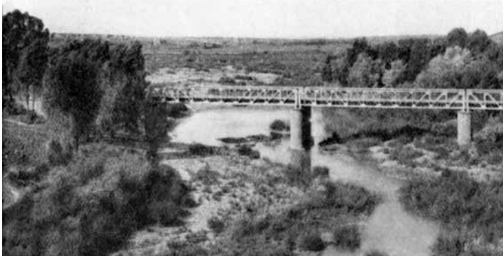
El puente de la Junta de los Ríos tendido en 1925, en una fotografía de E. Hernández Pacheco.
