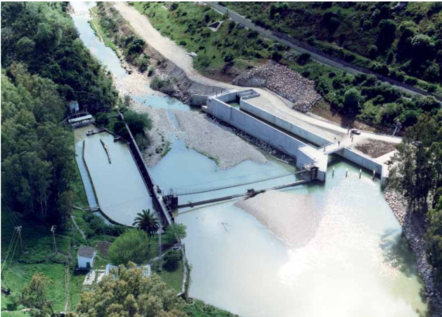
Azud de derivación en la cerrada de Buitreras para la toma en el Guadiaro, en 1998. FOTO: CONFEDERACIÓN HIDROGRÁFICA DEL GUADALQUIVIR.
