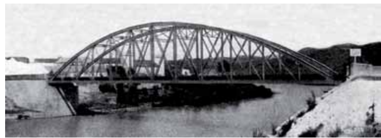
Puente de San Miguel de estructura metálica en Arcos de la Frontera, poco después de su terminación en 1920.
