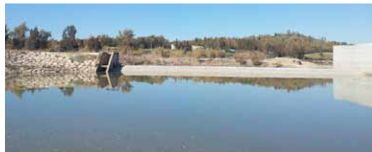
Tramo de labio del azud de El Portal. Foto: F. ZAMBRANO.
