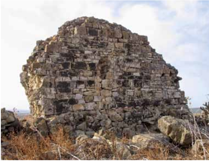
Torre de recepción del gran sifón del acueducto gaditano de Tempul en el Valle de los Arquillos (Torrecera, Cádiz). Foto: L. G. LAGÓSTENA BARRIOS.
