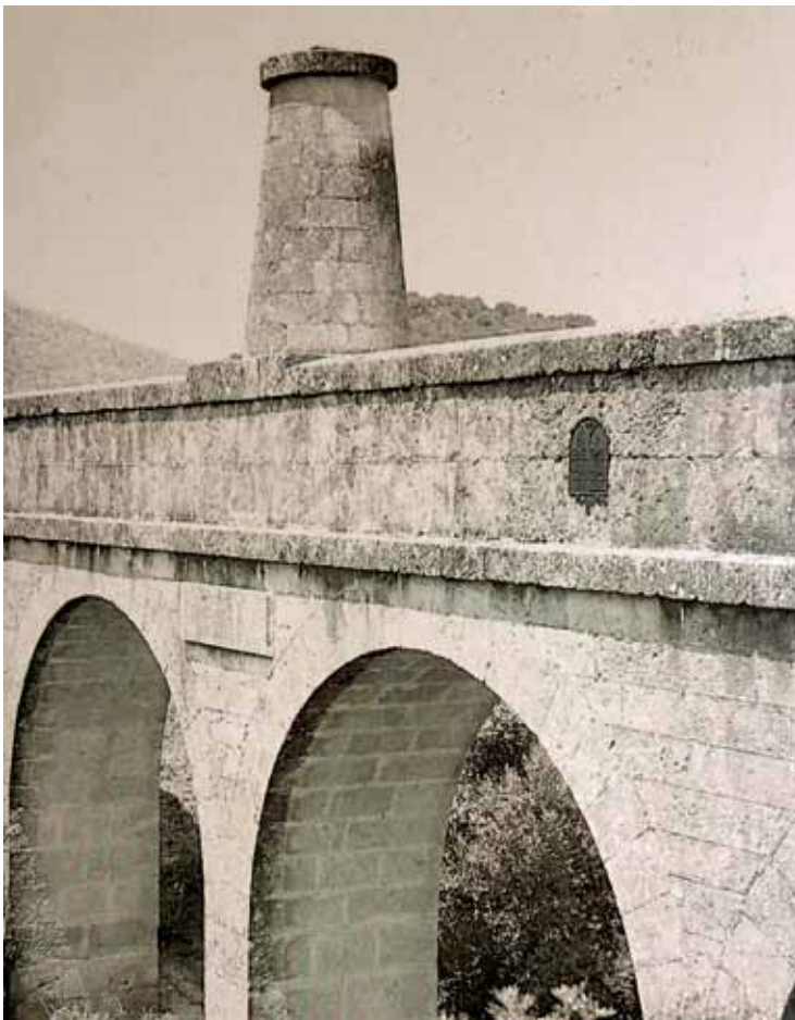
Acueducto sobre el arroyo Ojos Azules de la traída de aguas Tempul-Jerez de Ángel Mayo.
