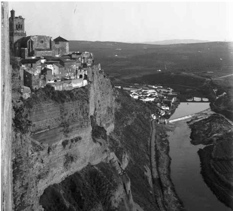
Vista del Guadalete desde Arcos a principios del siglo XX. Sobre el río se ven el puente de piedra y el azud del molino del Algarrobo. FOTOGRAFÍA DE J. M. DE LAS CUEVAS. FUNDACIÓN VÍCTOR MARÍN.
