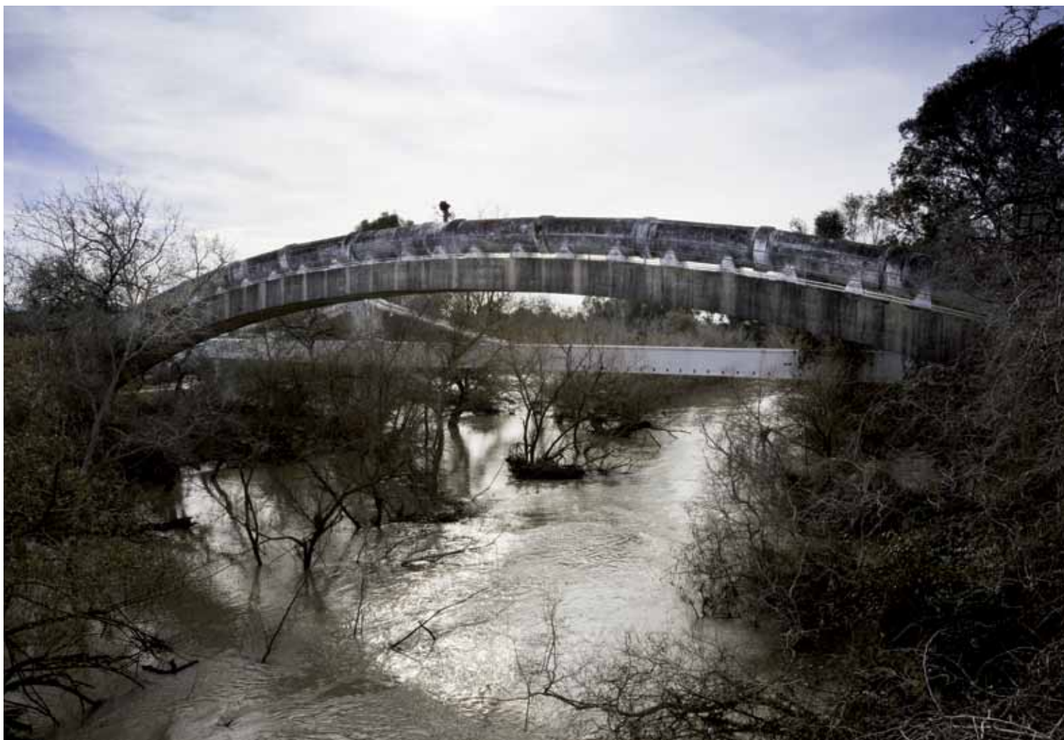
El río Guadalete durante la crecida del invierno de 2009-2010 a la altura del sifón de la Florida y el puente atirantado del acueducto de Tempul. Foto: J. MORÓN.
