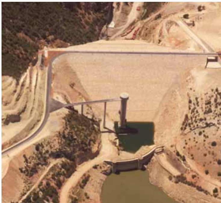
Vista aérea de la presa de Guadalcacín II durante su construcción a principios de los años noventa del siglo XX. Al pie de la gran pantalla de materiales sueltos de la nueva presa y de la torre de tomas se contempla la primera presa de Guadalcacín construida por el ingeniero González Quijano, que quedaría sumergida al llenarse el embalse. FOTO: CONFEDERACIÓN HIDROGRÁFICA DEL GUADALQUIR
