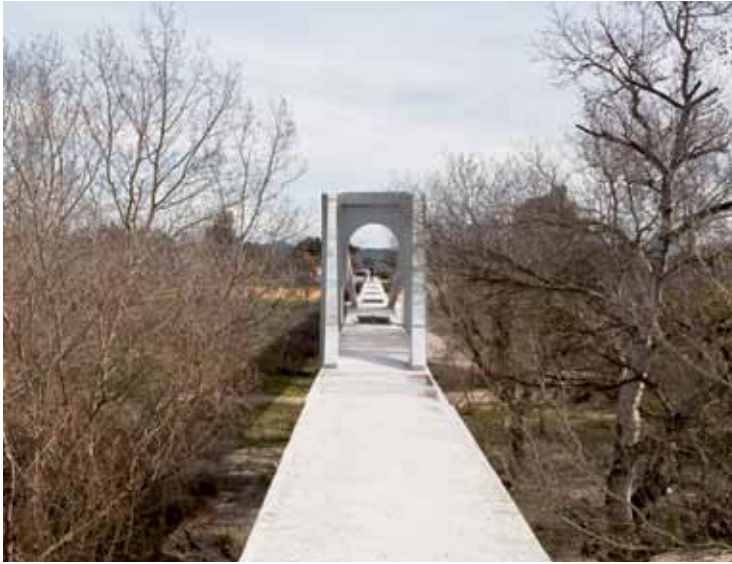
Perspectiva de la pasadera del acueducto-sifón de Tempul sobre el río Guadalete a la altura de la Barca de la Florida. Foto: J. Morón.
