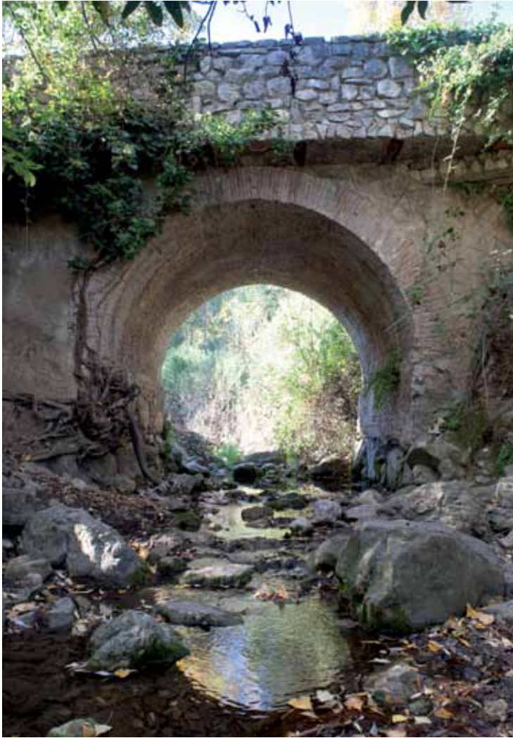
Uno de los puentes sobre el cauce al borde del casco urbano de Grazales. Foto: J. Morón.
