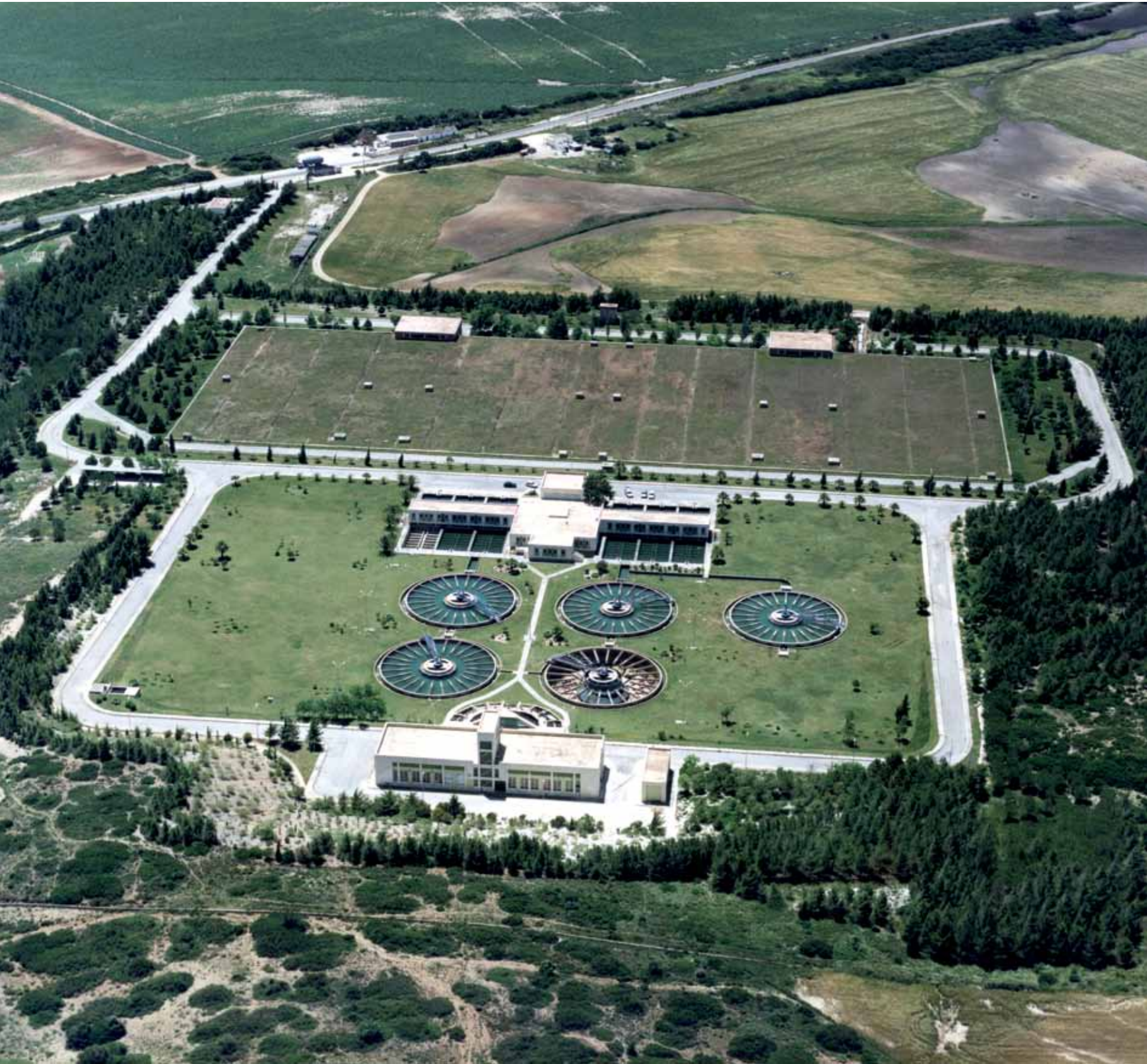
La planta o ETAP Montañés, en una imagen aérea de 1996. Foto: CONSORCIO DE AGUAS DE LA ZONA GADITANA.
