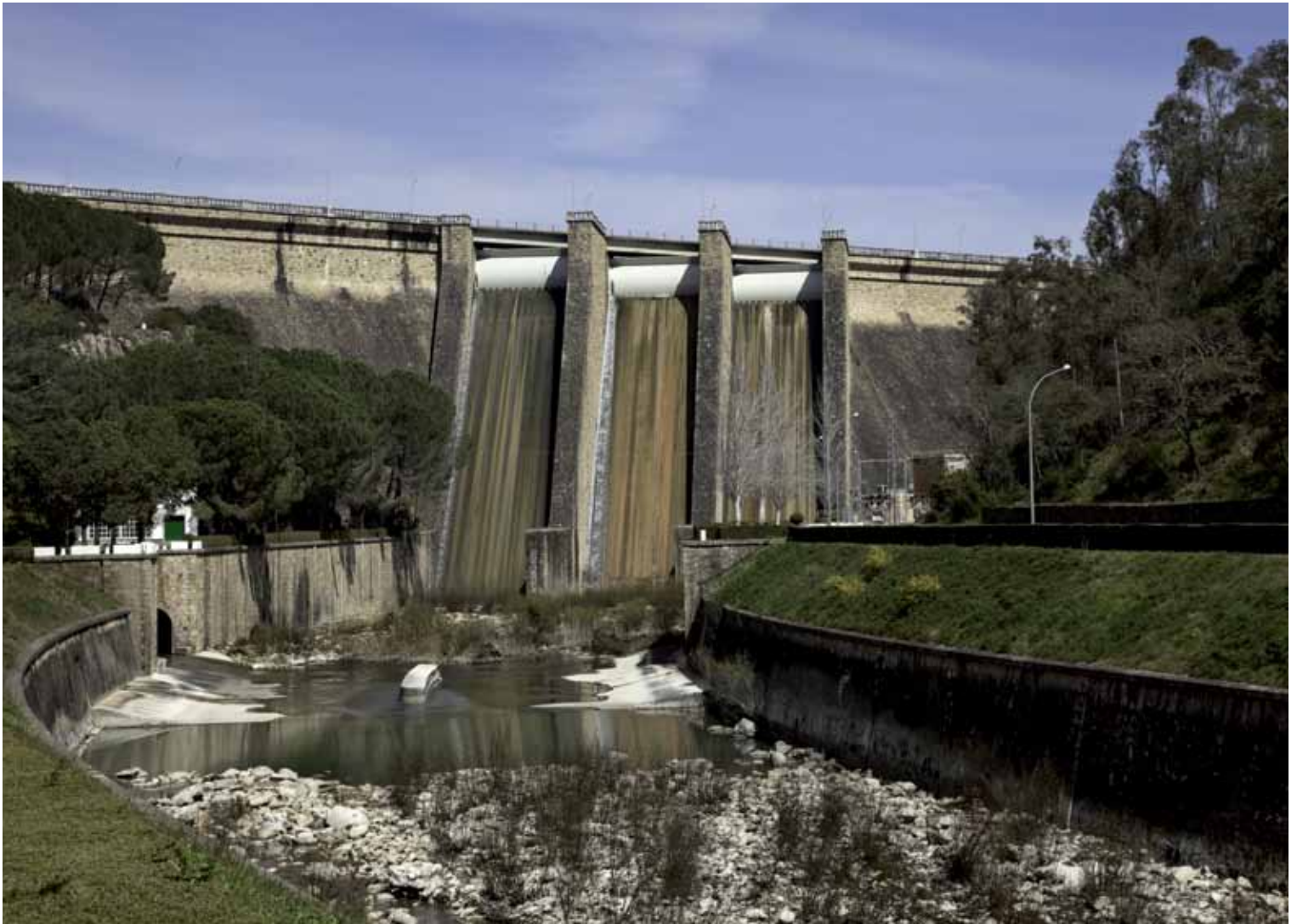
Presa de los Hurones, vista desde el cauce del Majaceite aguas abajo. Foto: J. Morón.
