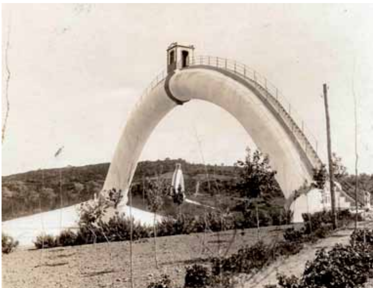
Sifones del Majaceite y Guadalete hacia las fechas de su terminación en la década de 1920.
