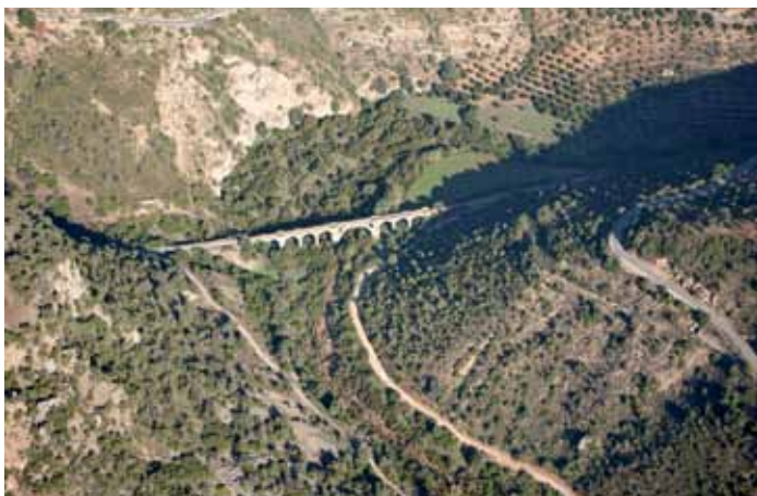
Viaducto sobre el Guadalporcún de la Vía Verde de la Sierra, en las inmediaciones de la estación de Coripe. Foto: J. HERNÁNDEZ.
