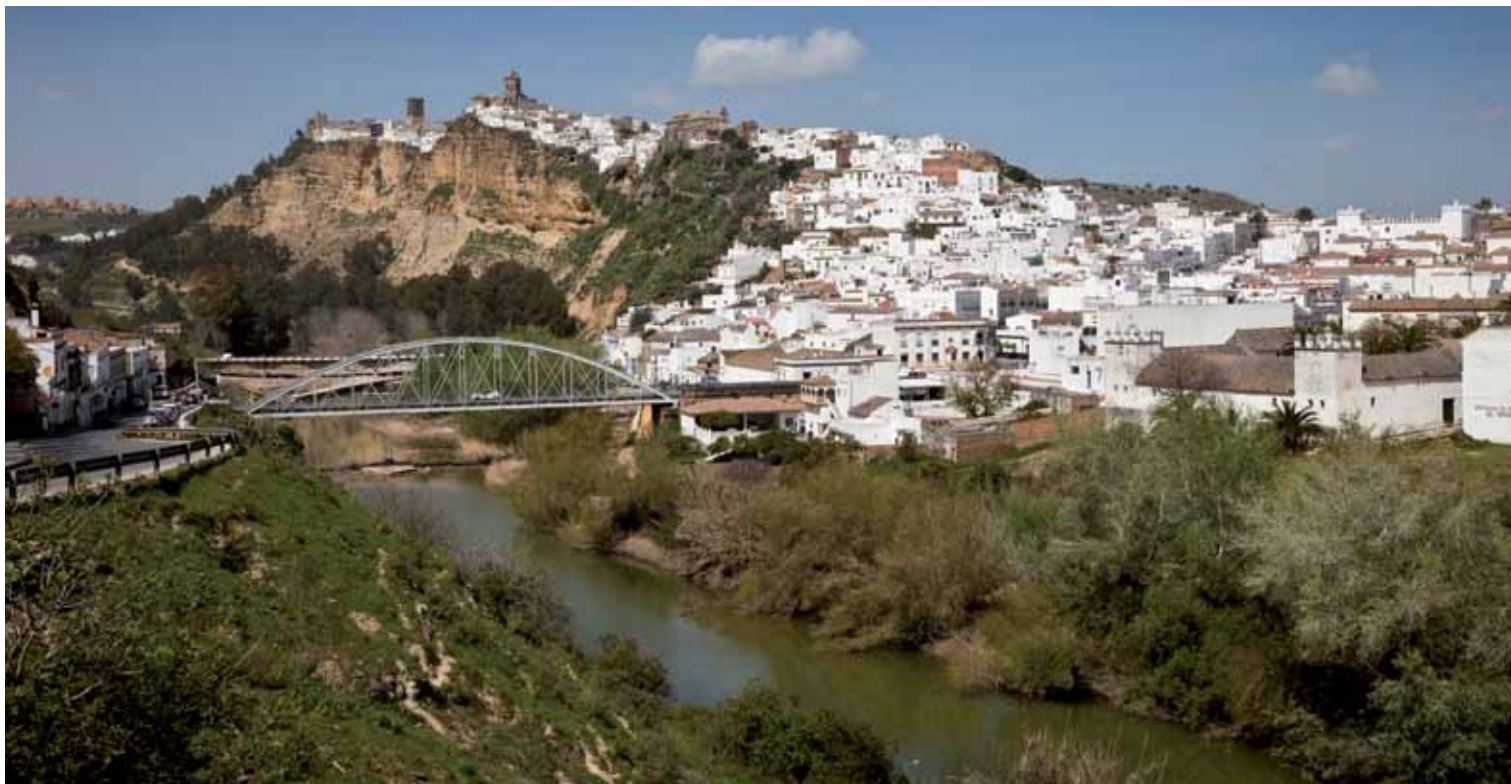
El Guadalete a su paso por Arcos de la Frontera, surcado por varios puentes. Junto a la orilla se distinguen las torres de contrapeso de las antiguas almazaras. Foto: J. MORÓN.
