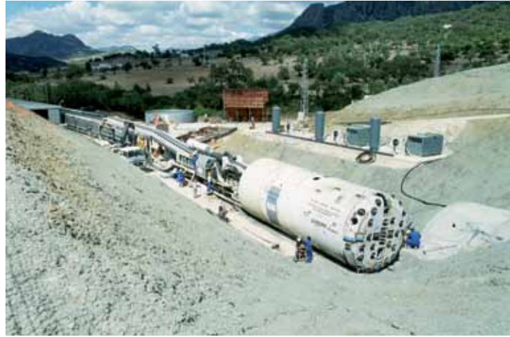
Tuneladora (TBM, Tunnel Boring Machine ) durante las obras de ejecución del túnel de trasvase. FOTO: CONFEDERACIÓN HIDROGRÁFICA DEL GUADALQUIVIR.
