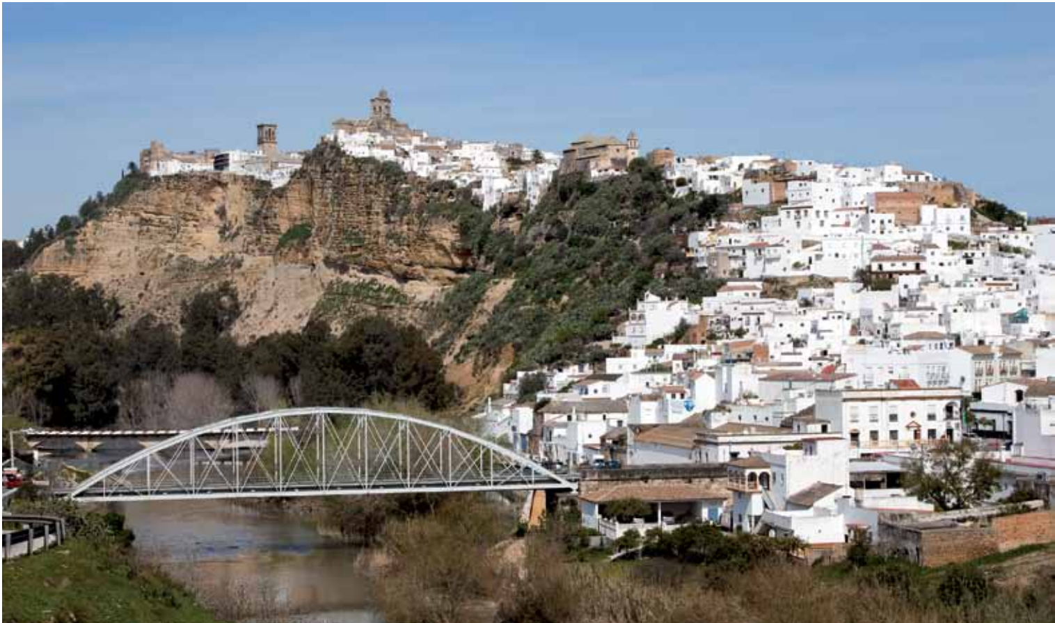
Imagen actual de Arcos de la Frontera, con el puente de San Miguel y, aguas abajo, el viaducto de construcción más reciente para paso de la carretera. Foto: J. Morón.
