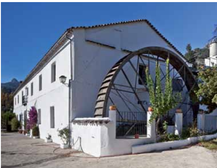
Antigua fábrica de mantas de Grazales, accionada mediante energía hidráulica. Foto: J. Morón.
