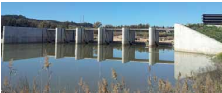
Azud con compuertas en la fase final de obras. Foto: F. ZAMBRANO.
