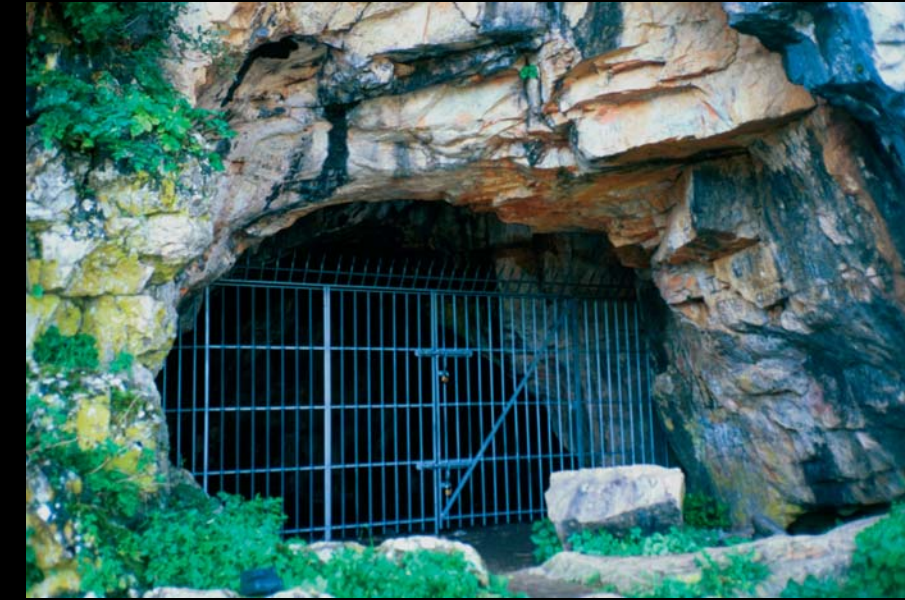
Cerramiento instalado en la Cueva de Santiago (Cazalla de la Sierra, Sevilla) para regular las visitas (foto: Elena Migens)
