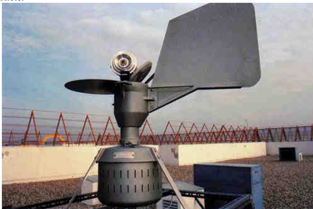
Figura 22: Captador polínico situado en azotea Univ Córdoba. Fuente, RAA.
