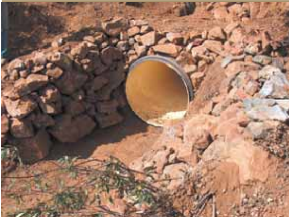
Adecuación de la entrada de una mina para permitir su utilización por las poblaciones de murciélagos.
