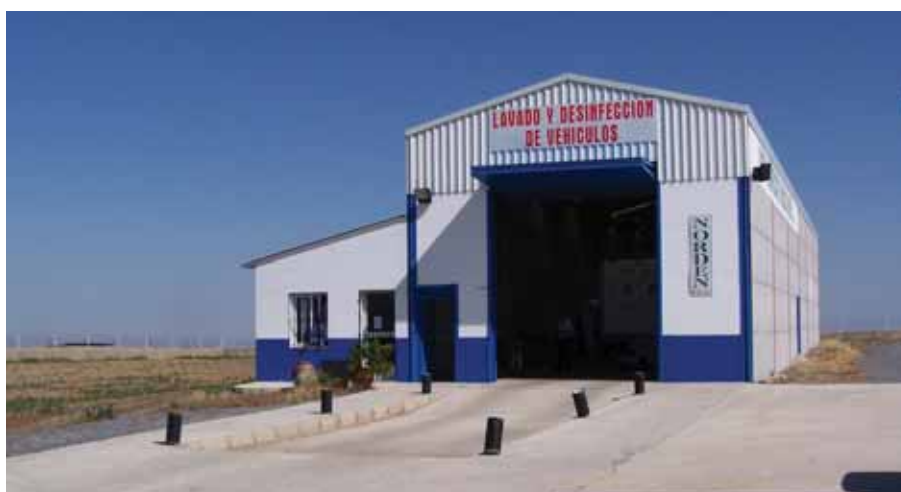
Figura 3. Centro de limpieza y desinfección de vehículos de transporte debidamente identificado
