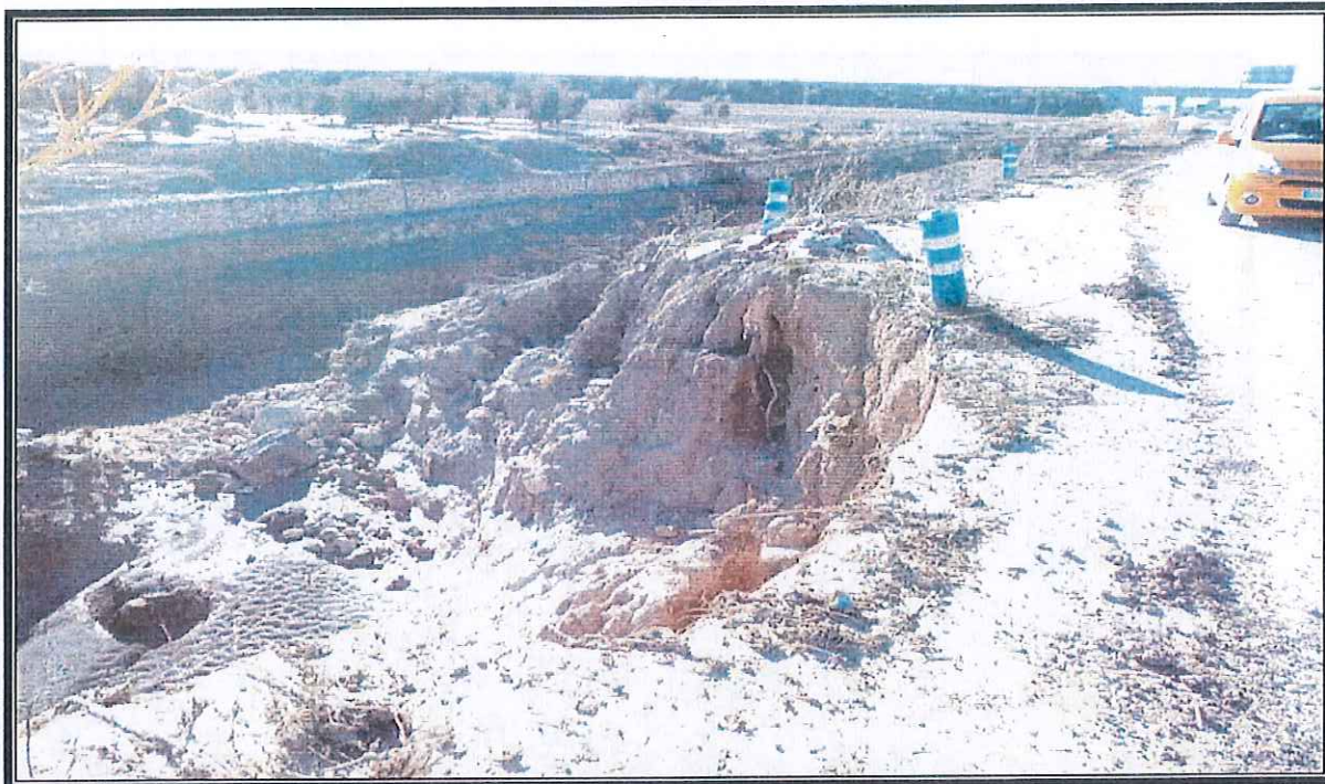
Erosión en bermas y barrera de seguridad descolgada.
