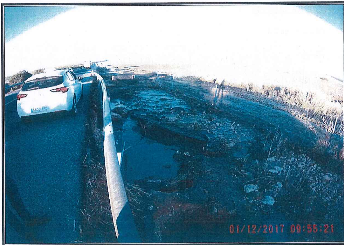
Erosión en bermas y barrera de seguridad descolgada.
