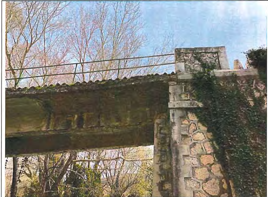
Foto 5.- Vista del tablero y estribo de la margen izquierda del río San Juan visto desde aguas abajo.
