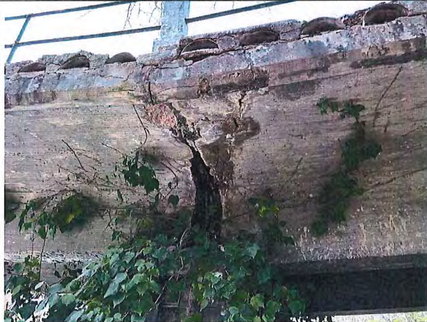
Foto 20.- Fisura generada por el asiento y desplome de la pila central, visto desde aguas arriba.
