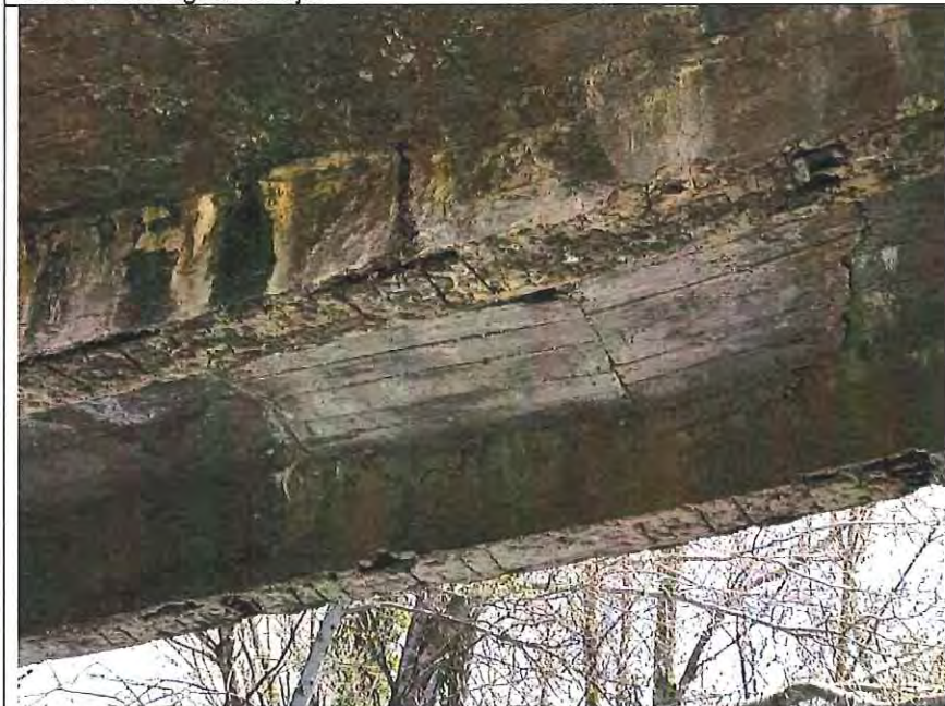
Foto 6.- Detalle del estado de recubrimiento y corrosión de las armaduras longitudinales y transversales del tablero, así como de una antigua reparación del mismo.
