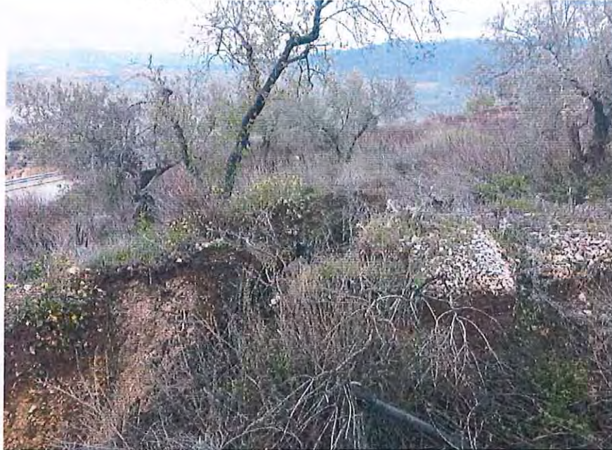
Grieta de rotura en el sector más próximo a Quesada.
