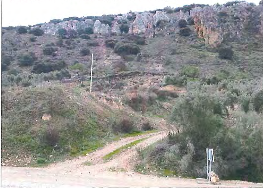
Zona del flanco Oeste del movimiento que desarrolla una grieta de tracción muy importante.
