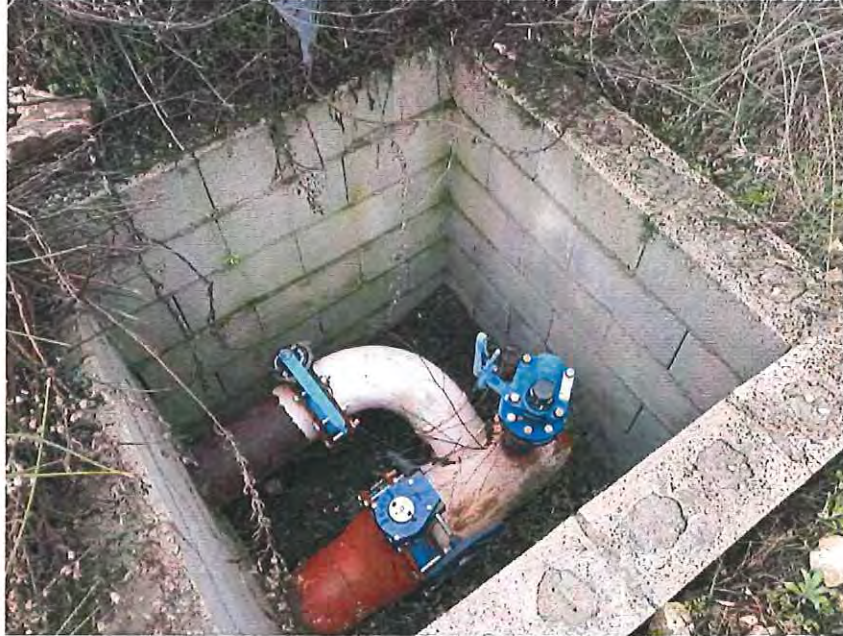
Conducción subterránea de agua.
