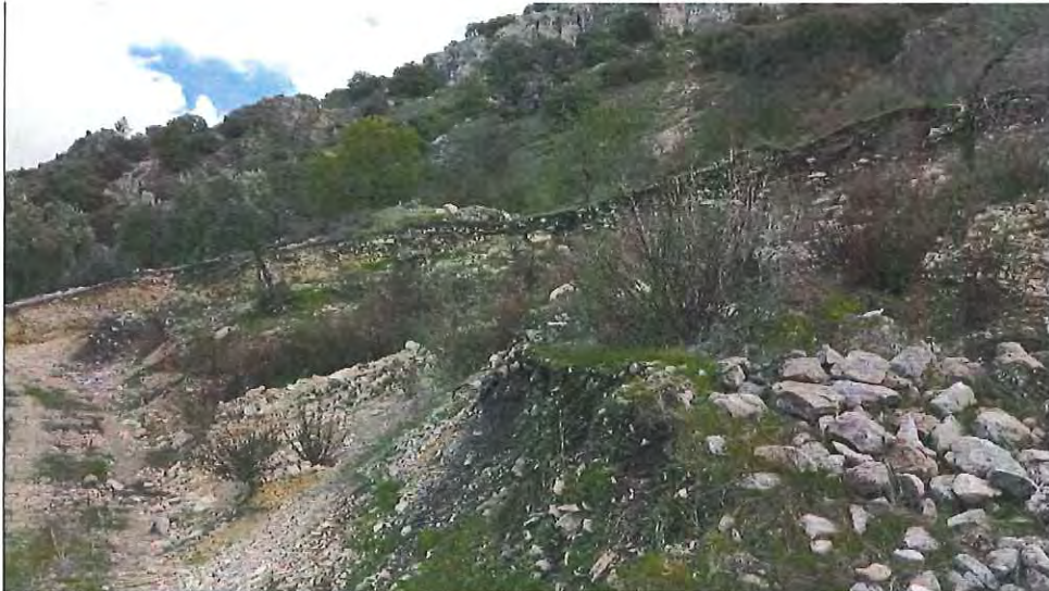
Zona de rotura y deformaciones en el sector próximo a la coronación del movimiento.
