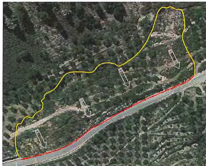
Movimiento y sus límites, junto con la afección a la calzada.
