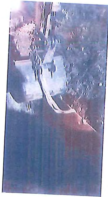
Colocación del chapón de acero para contener al agua. 1ª medida tomada para reducir el caudal de vertido.
