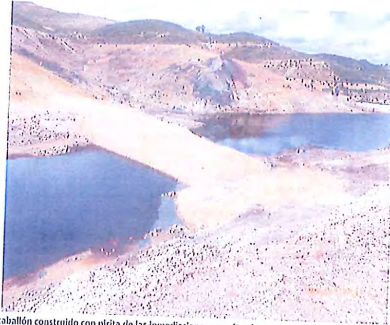
El caballón construido con pirita de las inmediaciones permite el acceso a la margen izquierda.
