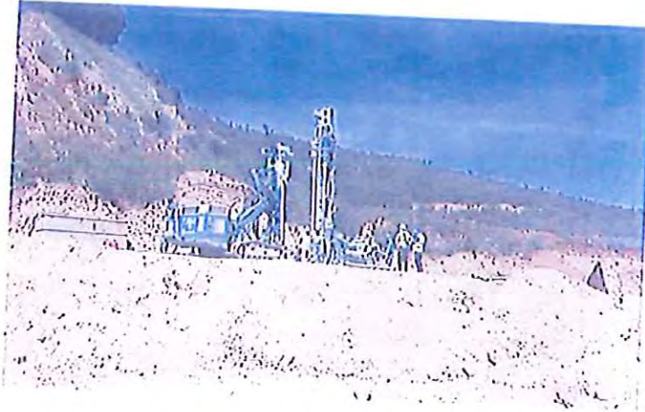
Trabajos de perforación. Dos perforadoras perforan en 200 y 160 mm y se instalan micro-pilotes formando dos pantallas para retención del hormigón que se inyecta a través de dos sondesos centrales.
