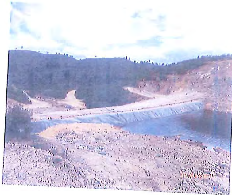
Presa nº 5 con PEAD, base y núcleo inferior de arcilla.
