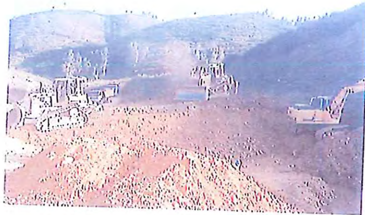
Momento durante la construcción de la presa de arcilla y PEAD. Trabajaron dos bulldozer, una retroexcavadora giratoria de cadenas, un rulo compactador y dos camiones carrilleros. Se aportó arcilla y material de las inmediaciones. La lámina de impermeabilización es PEAD de 1,5 mm.
