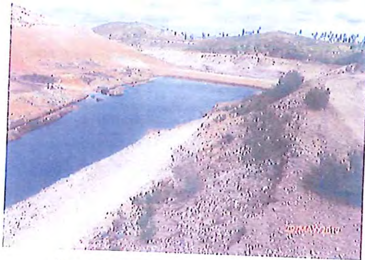
Presas nº 1. Aguas arriba. Situación actual del agua embalsada.
