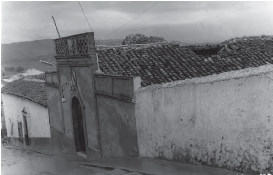
Antiguo Ayuntamiento de Olvera en La Calzada (1923-1963). En este edificio tuvieron lugar algunos de los sucesos más importantes ocurridos durante la República y la Guerra Civil
