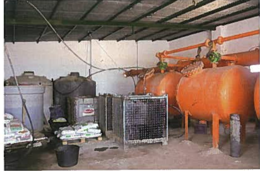
Fig. 23. Cabezal de riego provisional (F. Centro Las Palmerillas). Fig. 24. Instalación de cabezal de riego localizado.
