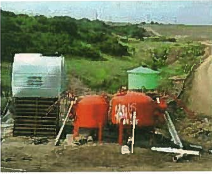
Fig. 23. Cabezal de riego provisional (F. Centro Las Palmerillas). Fig. 24. Instalación de cabezal de riego localizado.
