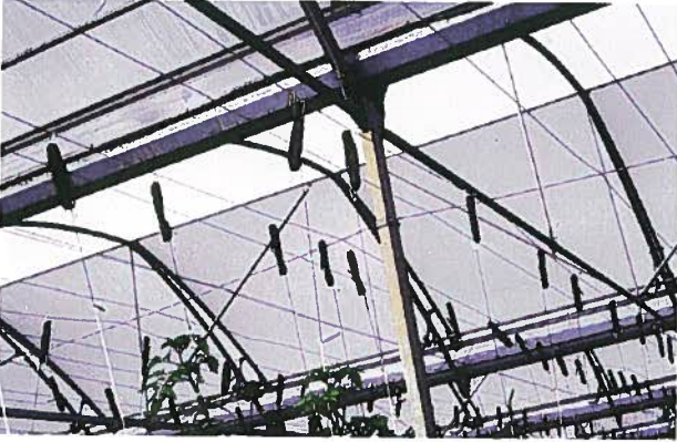
Fig. 119. Detalle de poleas.
