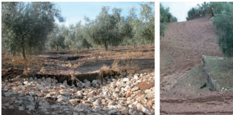
Figura 24: Ejemplos de pequeñas presas de retención para corrección de cárcavas.
