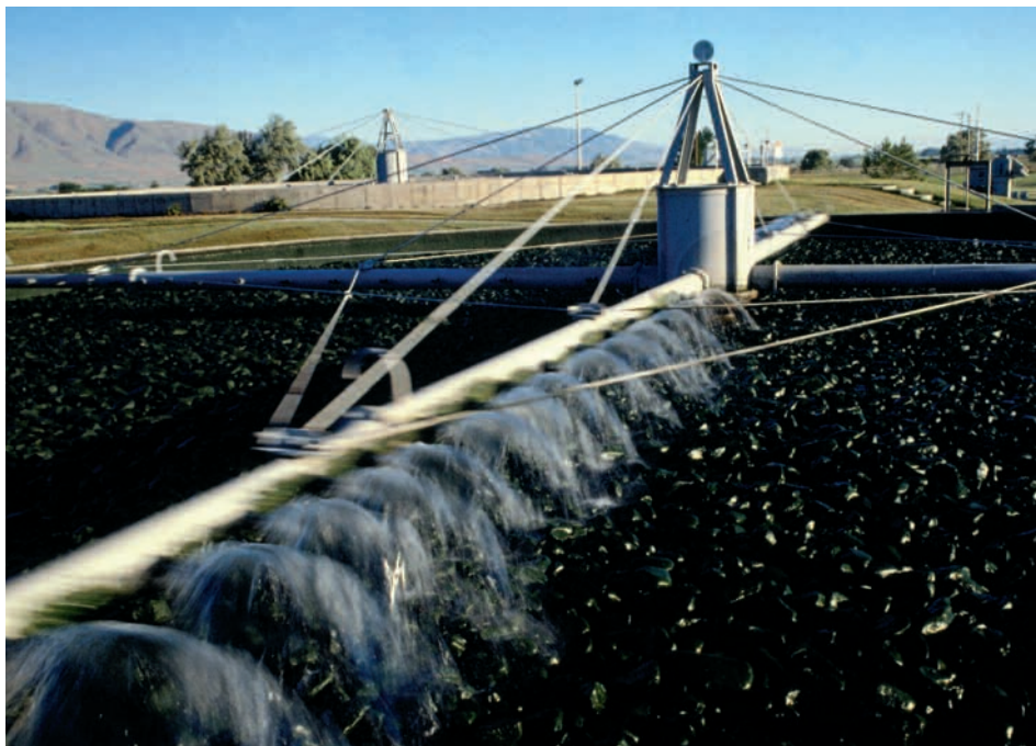
Planta de tratamiento de aguas residuales industriales
