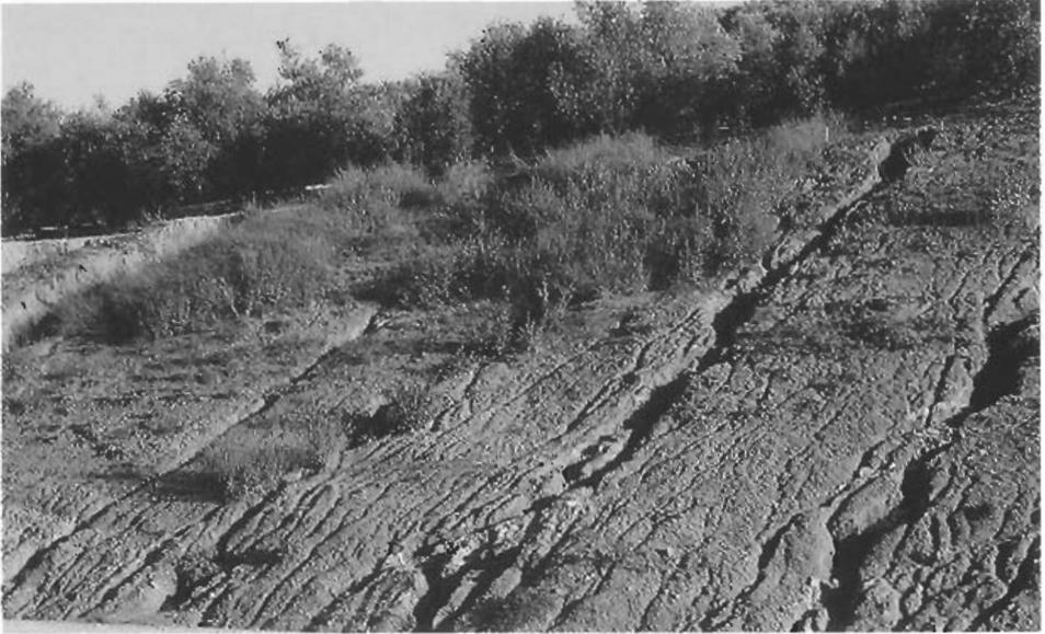
Foto 1. Talud con importantes cárcavas. Se aprecia que en la zona revegetada se ha disminuido considerablemente la pérdida de suelo y aguas abajo las cárcavas son mucho más pequeñas. Foto M. Saavedra.
