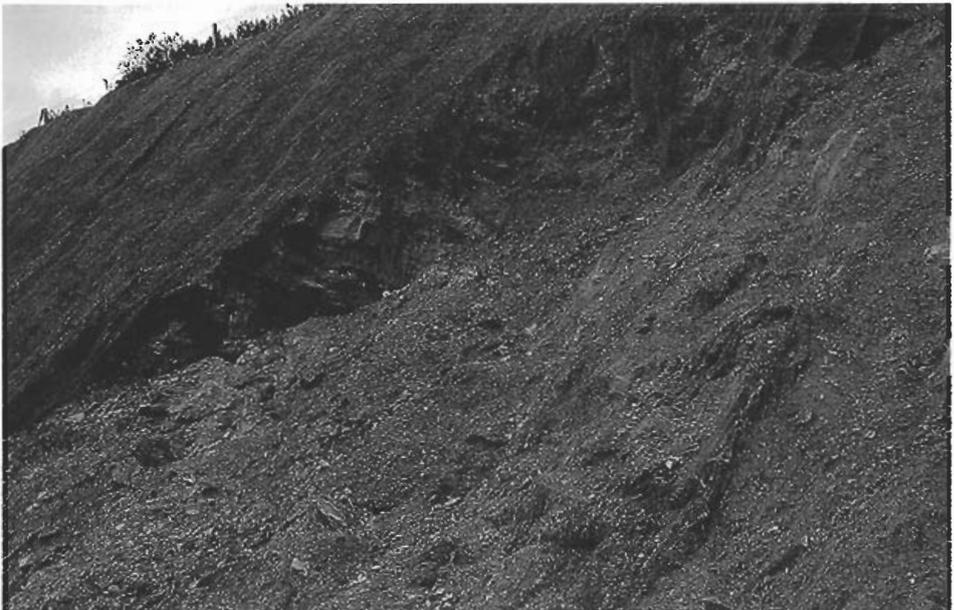
Foto 15. Talud de fuerte pendiente protegido con malla. La malla no ha resultado totalmente efectiva y se ha producido desprendimiento y rotura de la misma. Foto M. Saavedra.
