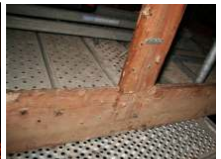
Fotos 068 a 070. El marco de la derecha cuando estaba apoyado en el andamio con el dosel unido. Esquina superior y centro superior e inferior. Se aprecian los refuerzos de pletinas metálicas de hierro clavadas y una nueva niquelada puesta en la intervención.
