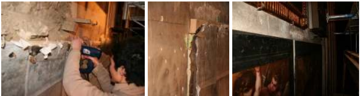
Fotos 078 a 080. Colocación de listones para desclavar y bajar el lienzo de la Visión de la Storta. Aspecto final definitivo antes de colocar el marco.
