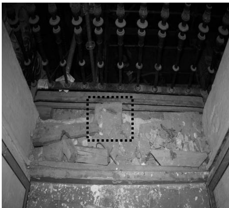
Foto 003. Detalles del balcón sobre el cuadro de S. Pedro antes. Remarcado la solería sobre el dosel del marco; a la derecha se ve el nuevo rodapiés.
