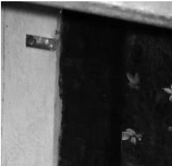
Fotos 172 y 173. Detalles de la pletinas en L colocadas para sujetar los cuadros al muro y listón sobre el que descansan los cuadros de mayor tamaño
