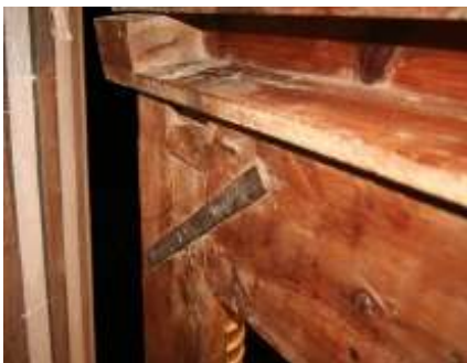
Fotos 068 a 070. El marco de la derecha cuando estaba apoyado en el andamio con el dosel unido. Esquina superior y centro superior e inferior. Se aprecian los refuerzos de pletinas metálicas de hierro clavadas y una nueva niquelada puesta en la intervención.
