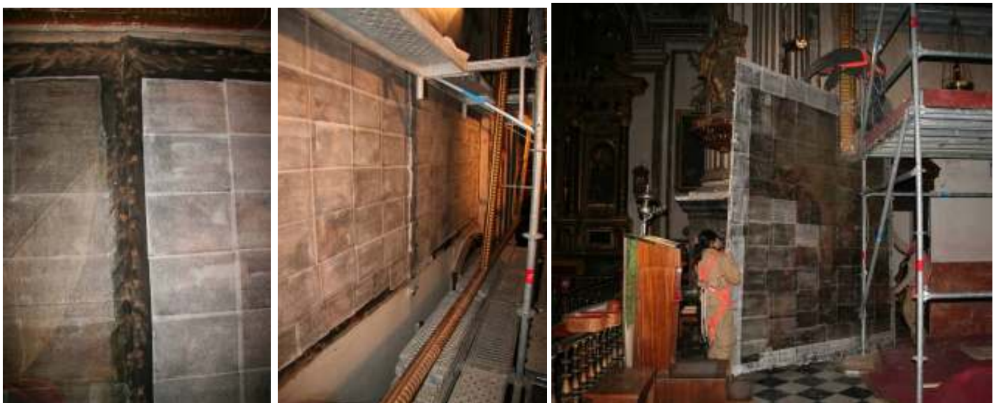
Fotos 081 y 083. Aspecto de la zona central de los cuadros de la izquierda tras separar el marco y empapelado de esa misma zona en los de la derecha; en estos últimos aún se ve el borde inferior sin empapelar y doblado hacia adentro. Foto 084. Descenso del lienzo de S. Ignacio herido en Pamplona.
