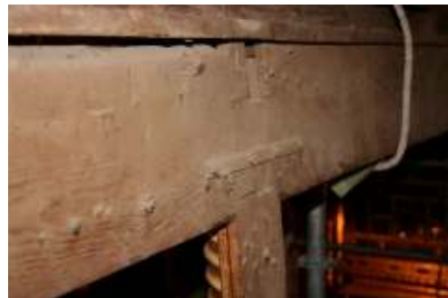
Fotos 068 a 070. El marco de la derecha cuando estaba apoyado en el andamio con el dosel unido. Esquina superior y centro superior e inferior. Se aprecian los refuerzos de pletinas metálicas de hierro clavadas y una nueva niquelada puesta en la intervención.
