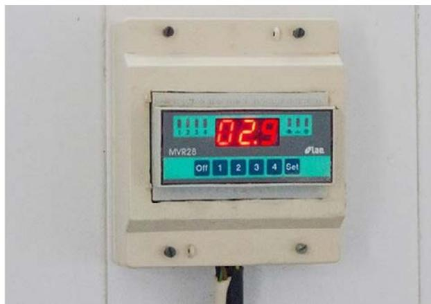
Display de seguimiento de la temperatura del tanque de frío
