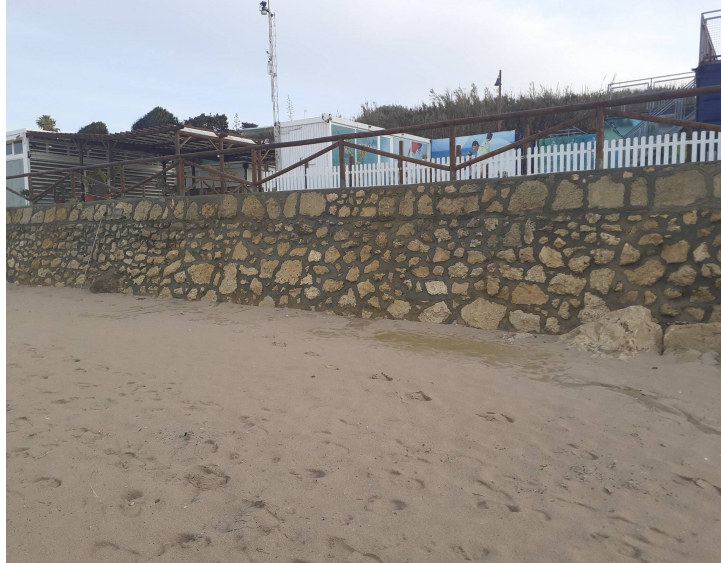
5.- Detalle de la elevación de la plataforma que sustenta el área de servicios sobre cota de playa alta.
