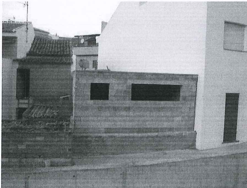
Ampliación (fachada posterior Almacén)
